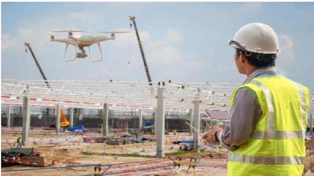
*Nota.* En esta figura se muestra un dron, realizando el vuelo fotogramétrico en una estructura de construcción. Adaptado de fotogrametría aplicada a la ingeniería, por CERSA 2022.
