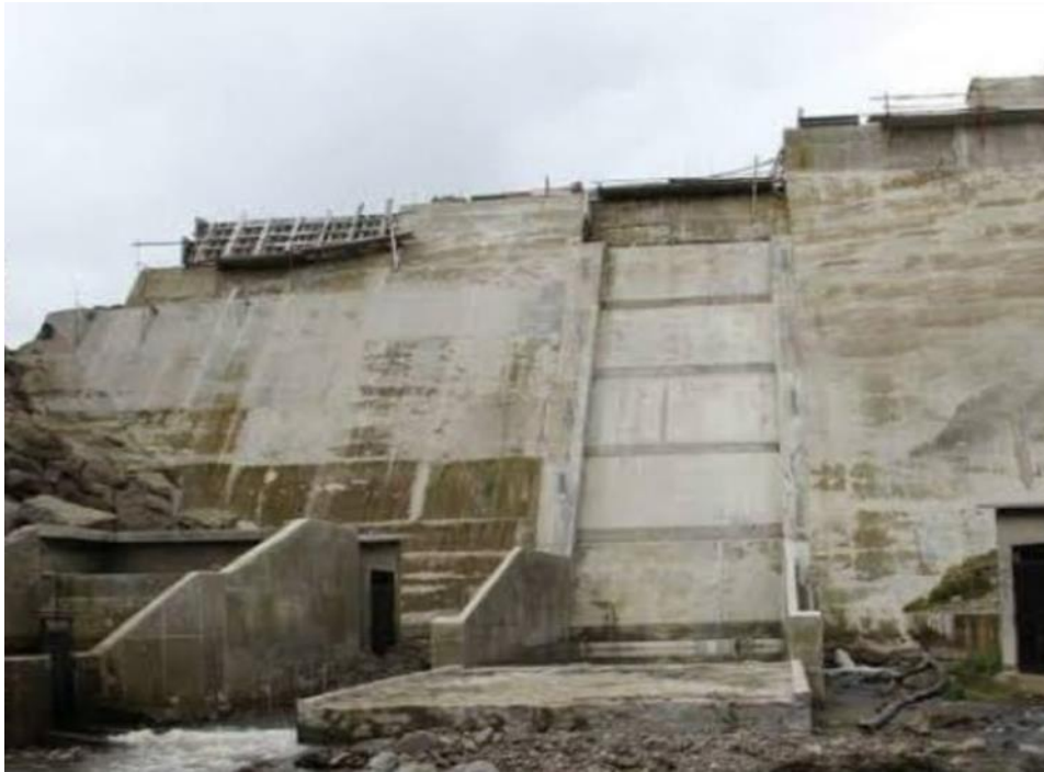
Anexo 21. Ejecución de la Presa Huacatina
