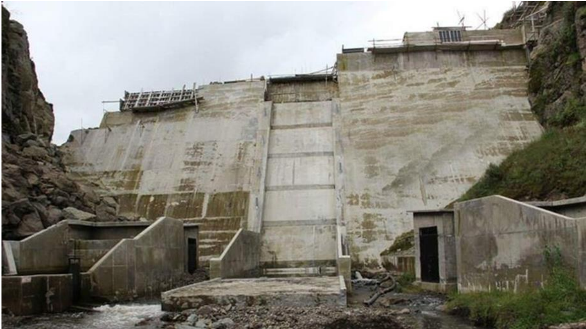
Anexo 23. Ejecución de la Presa Huacatina –vista inferior
