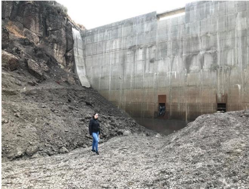
Anexo 7. Estribo izquierdo y embalse de la Presa Huacatina
