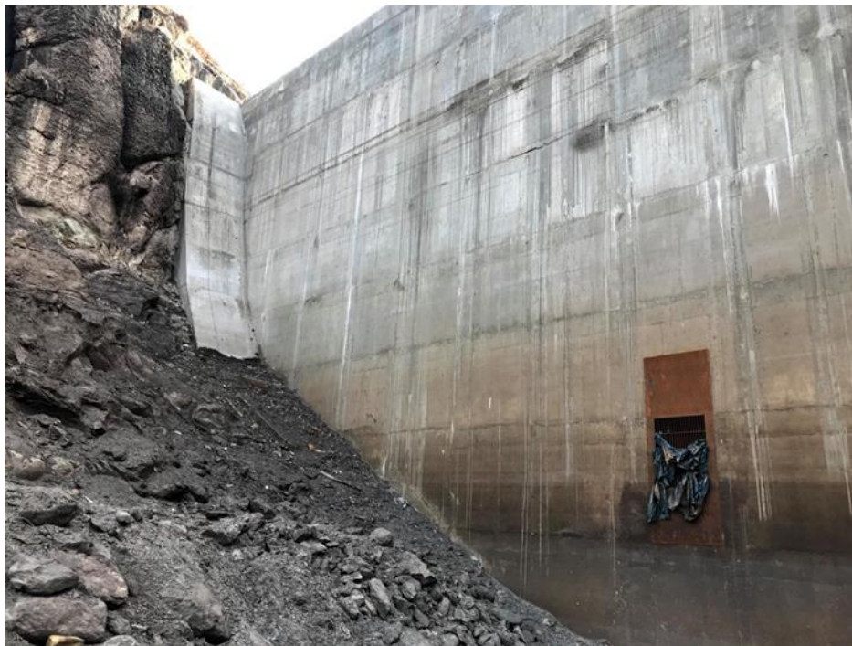
Anexo 6. Estribo izquierdo de la Presa Huacatina
