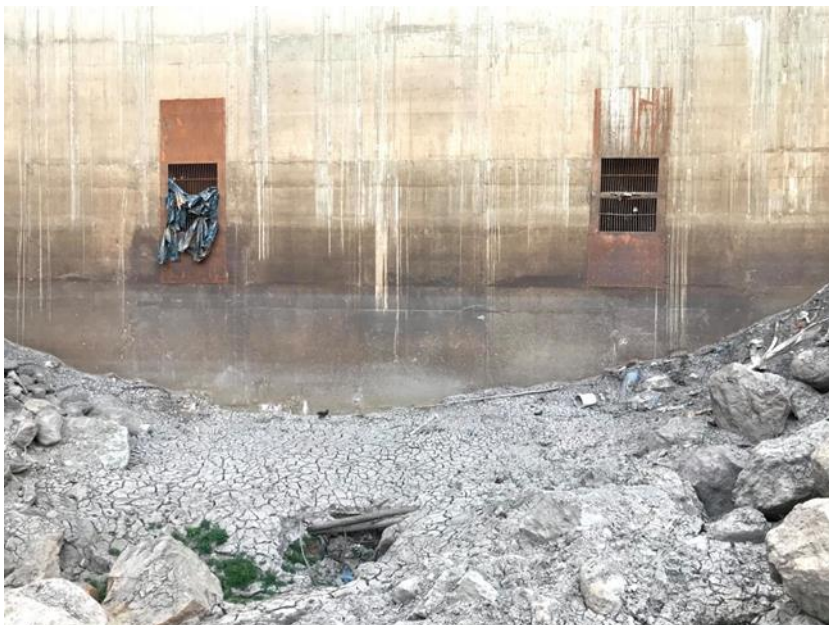
Anexo 2. Frente de la Presa Huacatina
