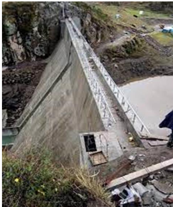
Anexo 22. Ejecución de la Presa Huacatina –vista superior
