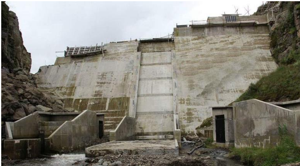
Anexo 20. Ejecución de la Presa Huacatina
