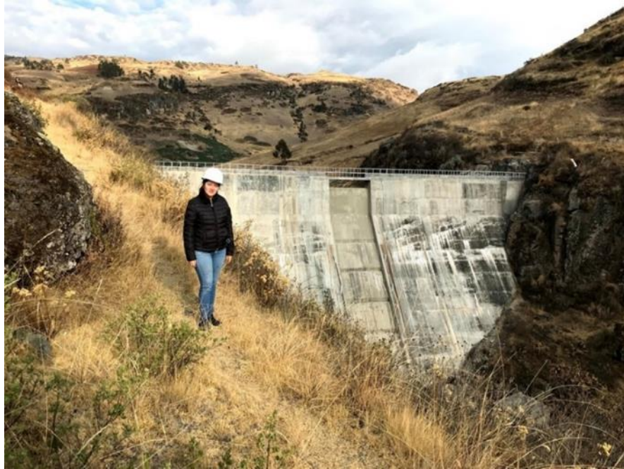
Anexo 9. Vista superior izquierda de la Presa Huacatina
