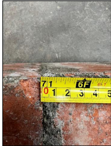
Figura 15 Espesor de la junta de mortero de 1cm
