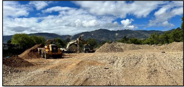
Figura 10 Cantera Huayrapongo – Baños del Inca - Cajamarca
