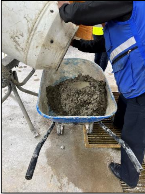
Figura 16 Mezcla de mortero
