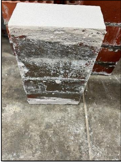
Figura 19 Enrasado de pilas
