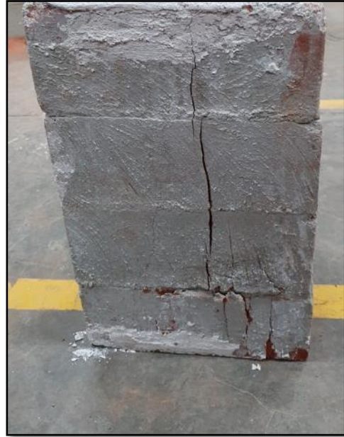
Figura 20 Falla de pila tras ser sometida a compresión
