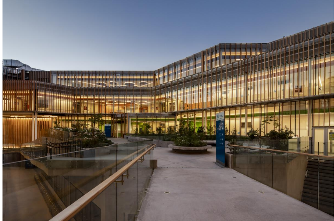
Figura 6. Vista general del caso N°2
