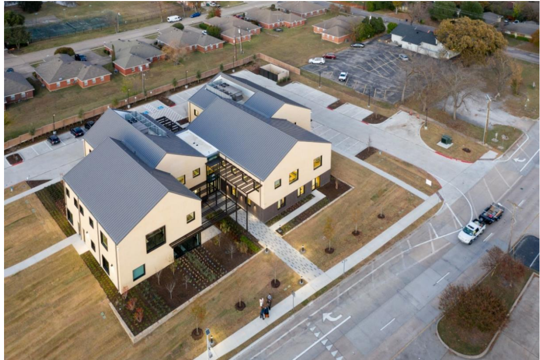
Figura 1. Vista general del caso N°1
