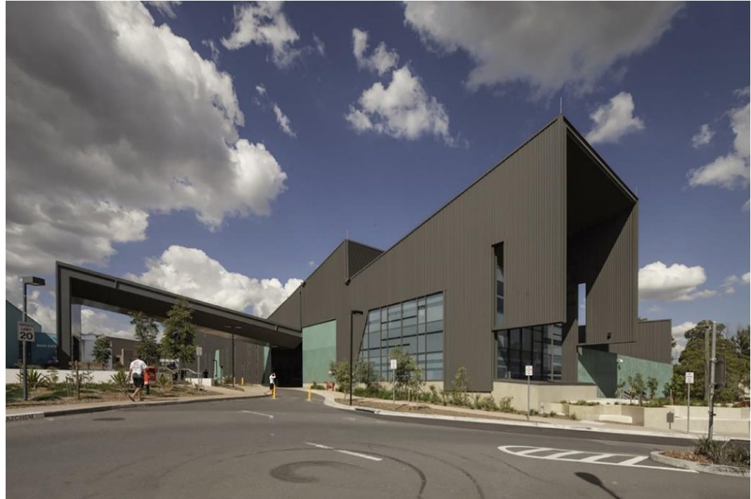
Figura 11. Vista general del caso N°3
