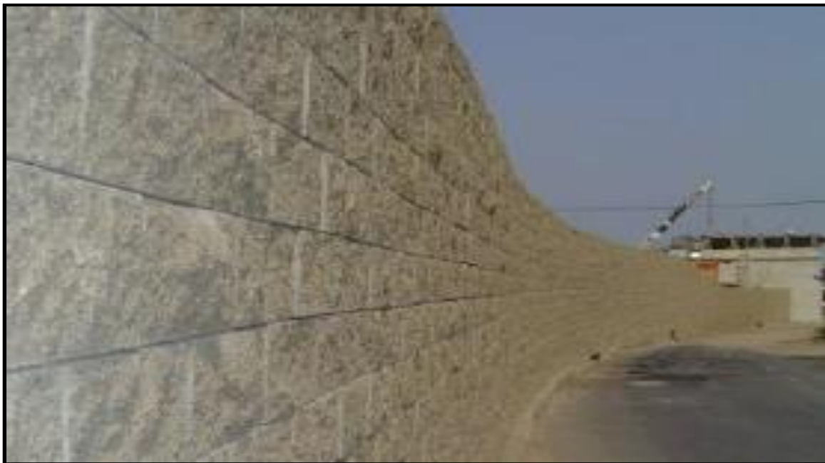
Acabado de Bloques
