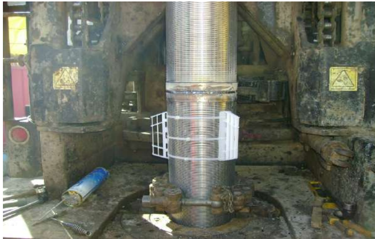
FIGURA 15. Instalación de Casing Fuente: Drillex International Perú SAC
