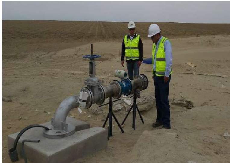
FIGURA 25. Pozo culminado para bombear agua para riego de terrenos de cultivo Fuente: Drillex International Perú SAC
