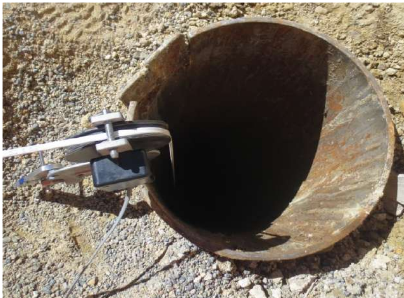
FIGURA 24. Instalación de cámara para verificar estado del pozo
