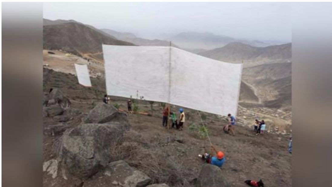
Figura n° 2.4. Fotografía de Atrapanieblas en los cerros de Villa María del Triunfo.
