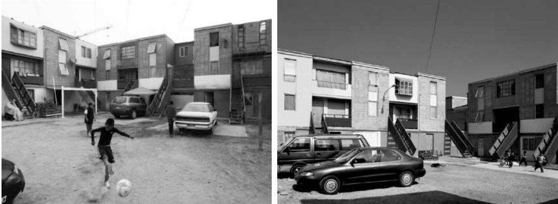
Gráfico 2.134: Espacios semipúblicos comunes, funcionan tanto de estacionamiento como área recreativa. 13
