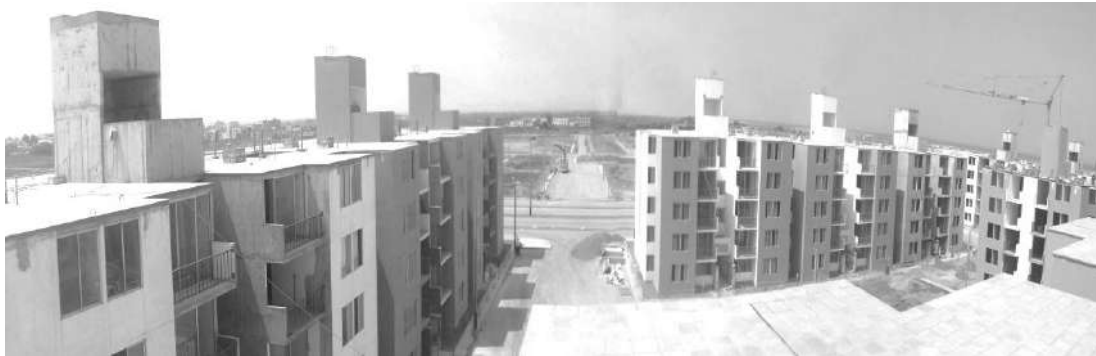
Gráfico 2.68: Vivienda multifamiliar en la Residencial Magisterial "El Golf" - Fuente: CV Project.
