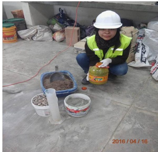
Fotografía 12: Utilizando aditivo Sika Cem Plastificante.
