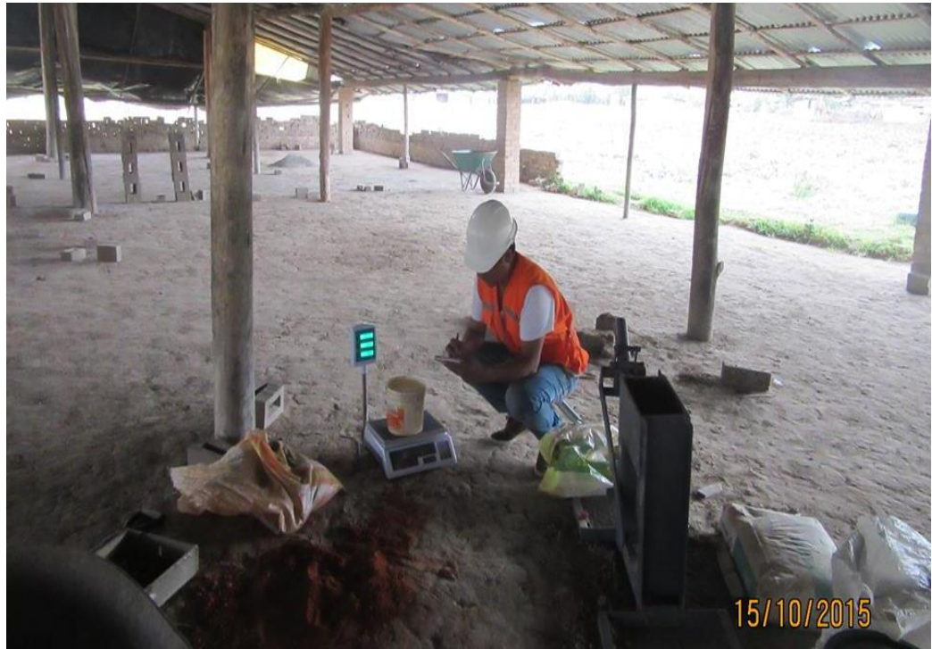
Fotografía 32. Peso del agua para la dosificación
