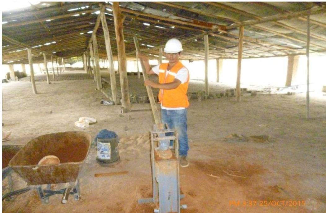
Fotografía 34. Elaboración de adobes con la máquina CINVA RAM en la cantera
