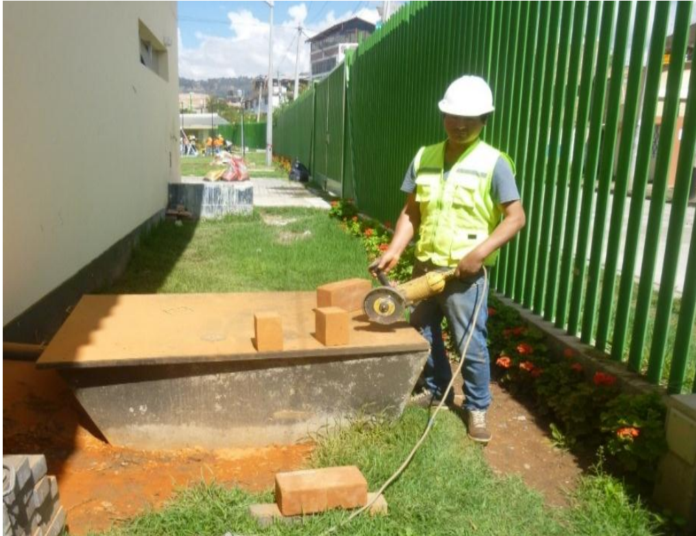
Fotografía 40. Realizando corte del adobe por mitades con amoladora en la Universidad Privada del Norte.
