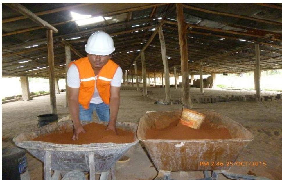
Fotografía 12. Preparación del material de acuerdo al óptimo contenido de humedad sacada del laboratorio mediante el ensayo de Proctor.
