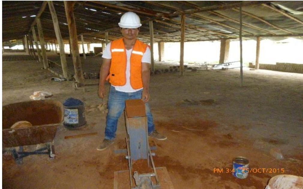
Fotografía 13. Elaboración del adobe mediante máquina de CINVA RAM
