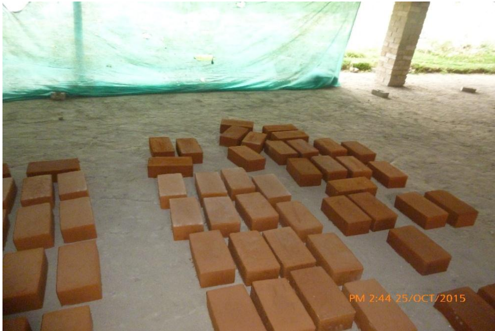
Fotografía 38. Secado del adobe y protección del aire mediante mantas.
