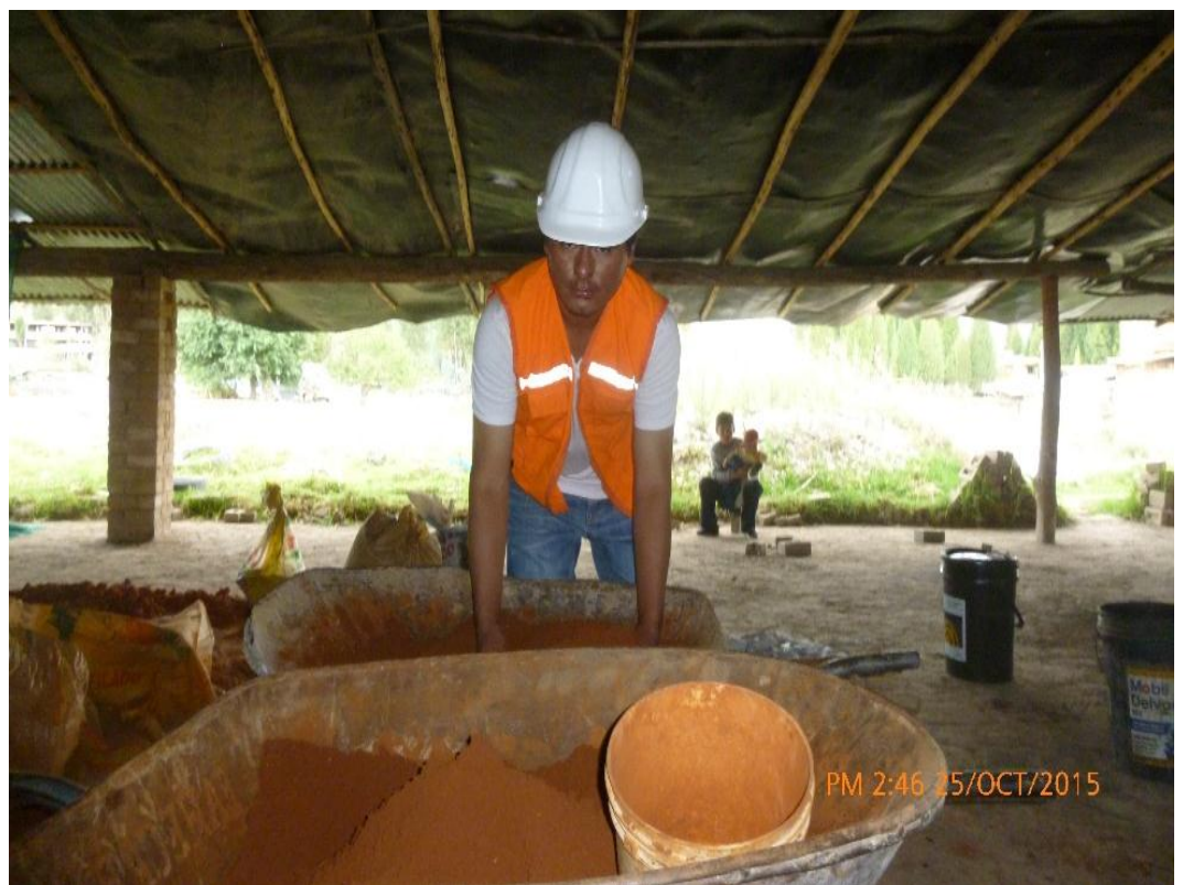
Fotografía 33. Preparación de la mezcla
