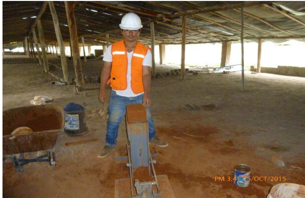
Fotografía 36. Elaboración de adobes con la máquina CINVA RAM en la cantera.
