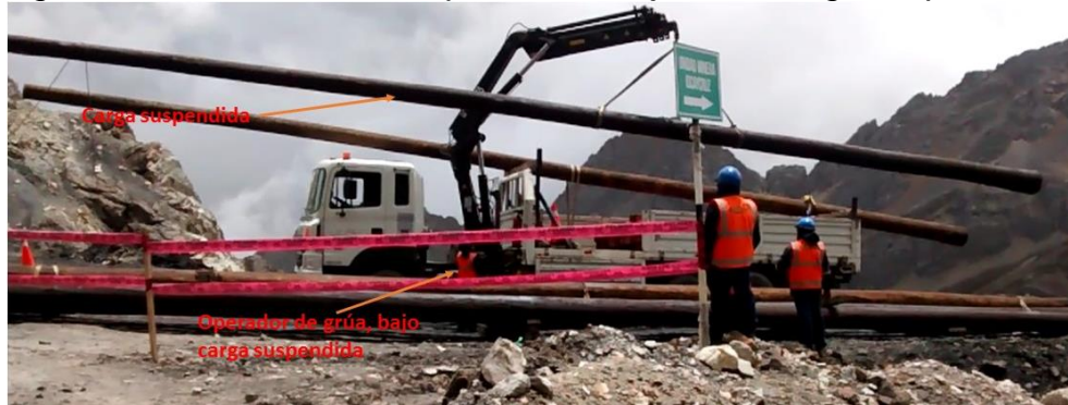
Figura n.º 8, Se muestra al operador debajo de la carga suspendida.
