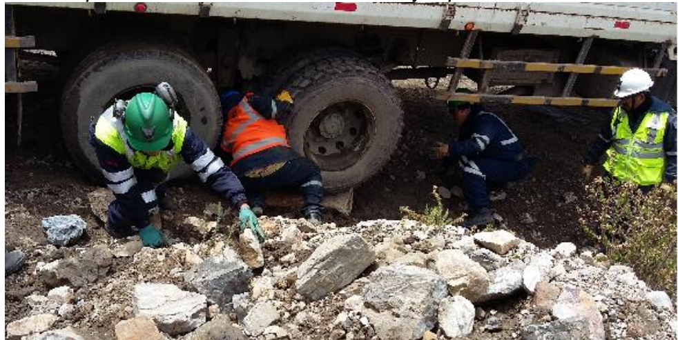
Figura n.º 14, Grúa Hyundai con problemas para salir de una curva cerrada por no tener tracción en los dos ejes posteriores.
