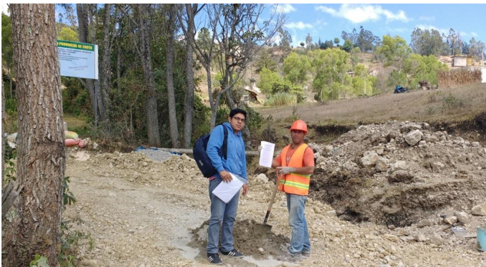
Aplicando instrumento de recolección de datos (encuesta a obrero), realizado en la obra “Mejoramiento del Camino Vecinal La Iraca Sector Corralillo”.
