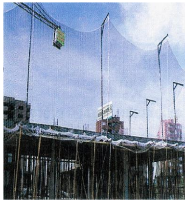
FIGURA N° 08. Redes de protección.
