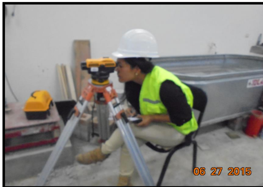
FOTO N° 26: Medición de deformación de viga con nivel de ingeniero.
