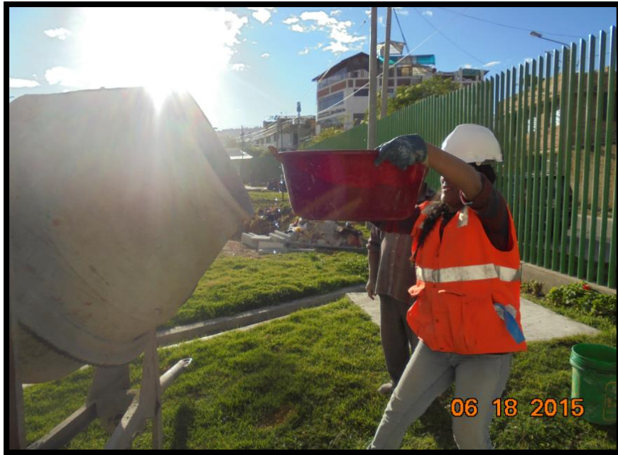
FOTO N° 21: Elaboración de mezcla de concreto para vigas.
