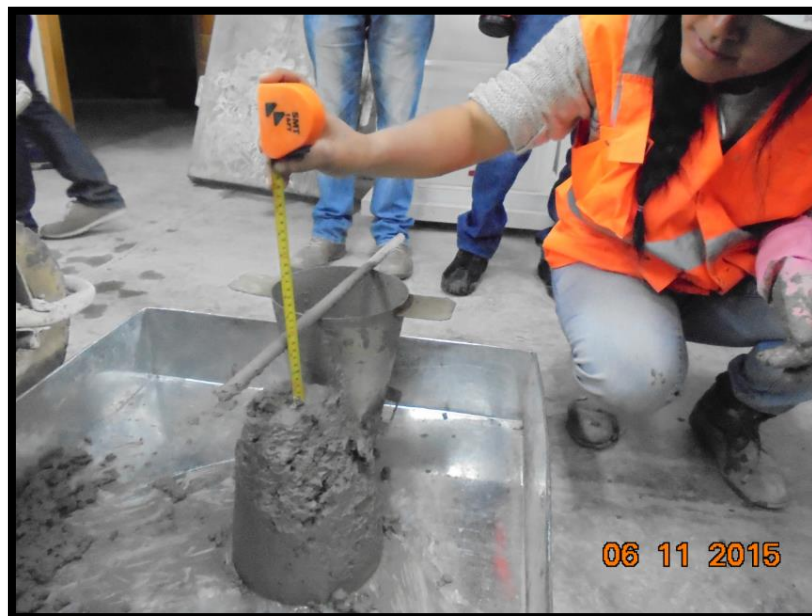
FOTO N° 18: Ensayo de asentamiento de concreto para vigas.
