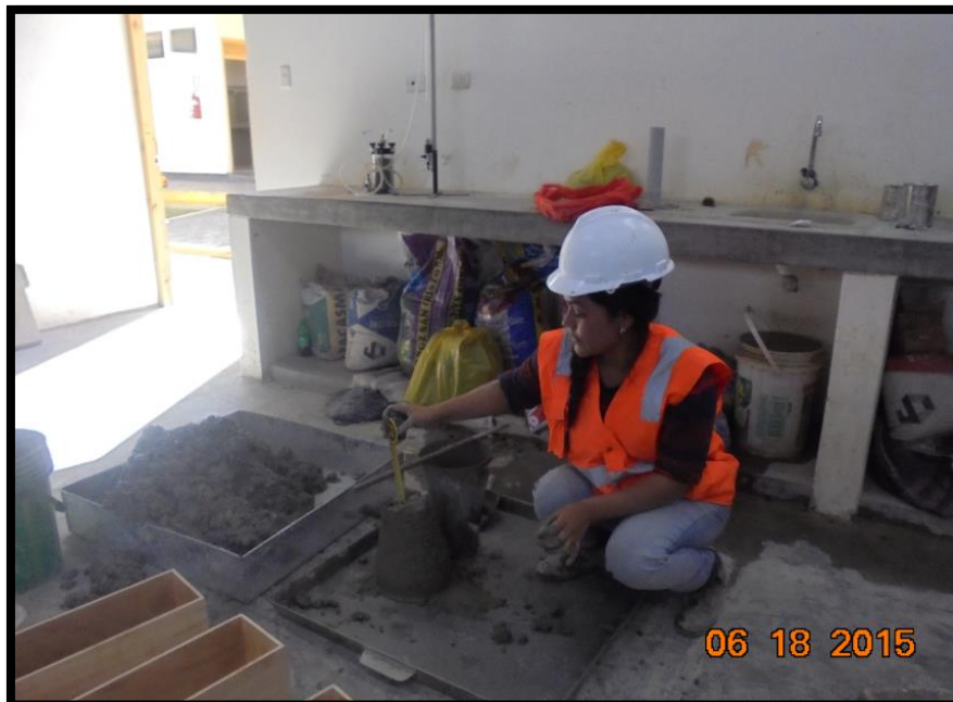
FOTO N° 22: Ensayo de asentamiento del concreto fresco para vigas.
