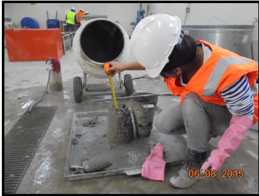
FOTO N° 15: Ensayo de asentamiento del concreto fresco.
