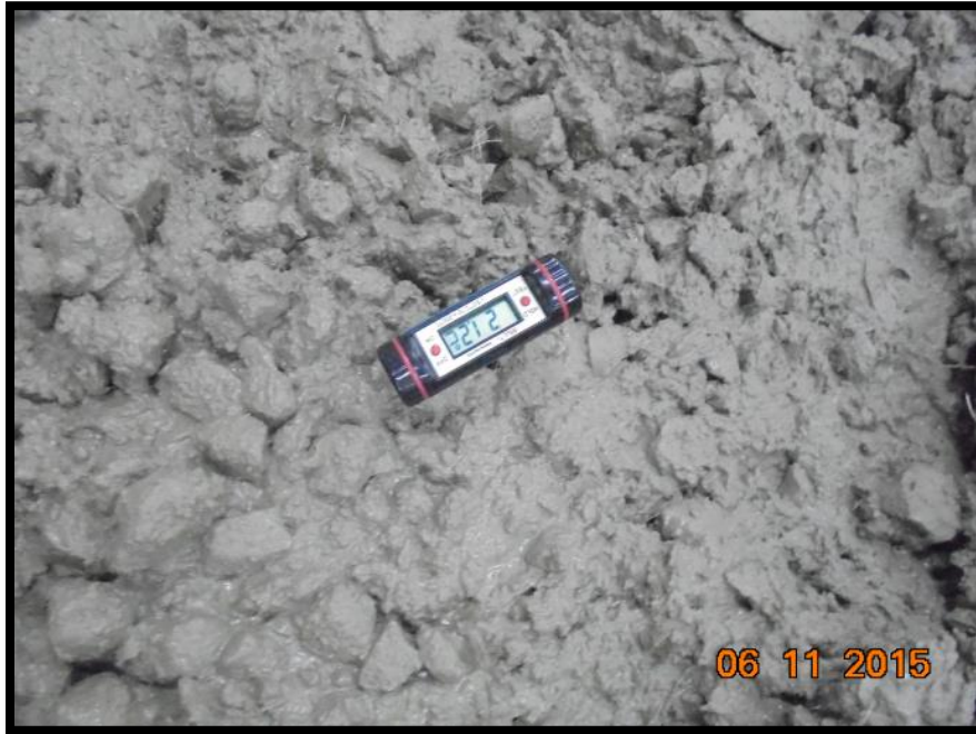
FOTO N° 19: Ensayo de temperatura de la mezcla del concreto.
