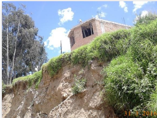
Imagen N° 11. Situación actual parte alta de la quebrada Cruz Blanca.
