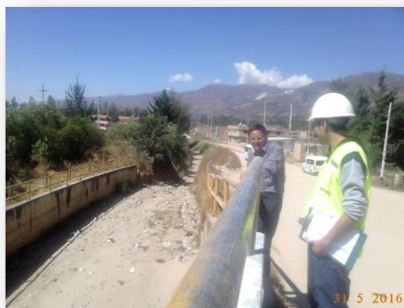
Imagen N° 10. Cambio de la sección de la quebrada en la Av. San Martín.
