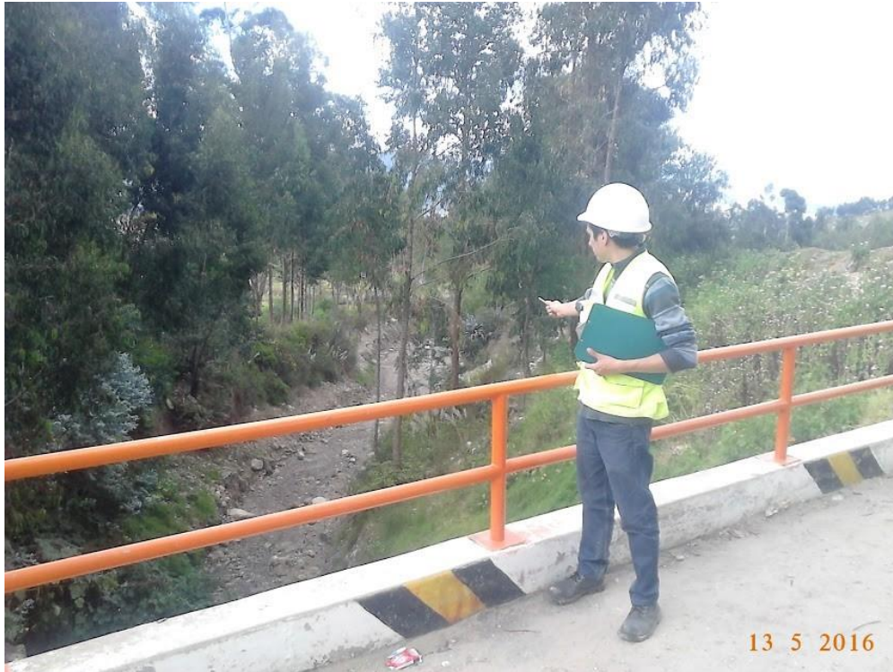
Fotografía N° 5. Puente Av. Independencia.
