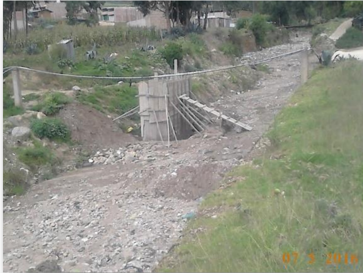
Imagen N° 19. Puente en construcción en el sector 14.
