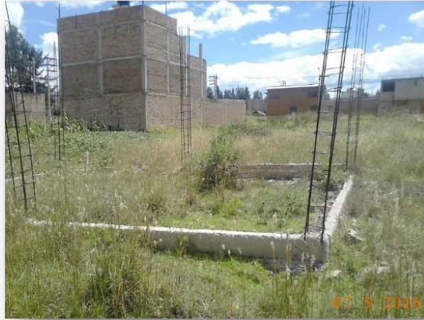
Imagen N° 29. Viviendas en construcción en el sector 23 de la zona de estudio.
