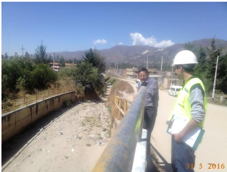
Fotografía N° 10. Asesor y Tesista en el puente de la Av. San Martín.
