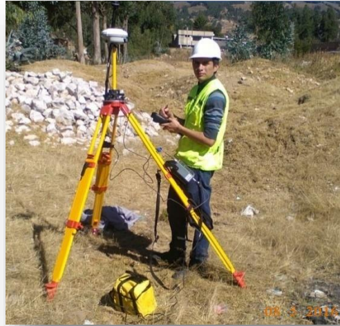
Imagen N° 33. Levantamiento topográfico de la zona de estudio.
