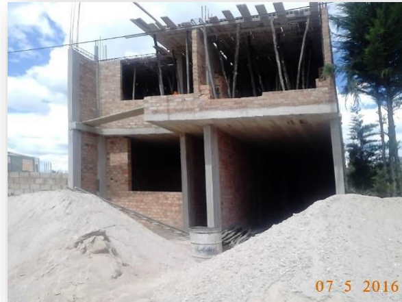
Imagen N° 31. Vivienda en construcción del Lote 2010 de la zona de estudio.
