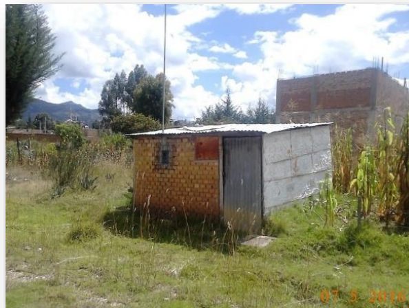
Imagen N° 32. Vivienda menor del Lote 2010 de la zona de estudio.
