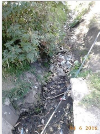
Imagen N° 49. Sección en la parte aguas arriba en el caserío Hayllapampa.
