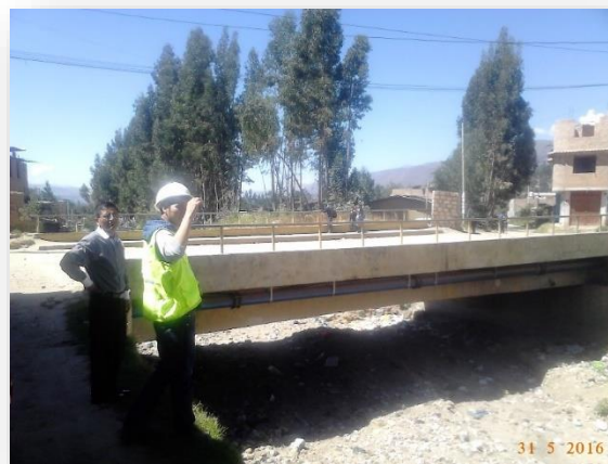
Imagen N° 34. Puente en el sector 19 en la Av. La Paz.
