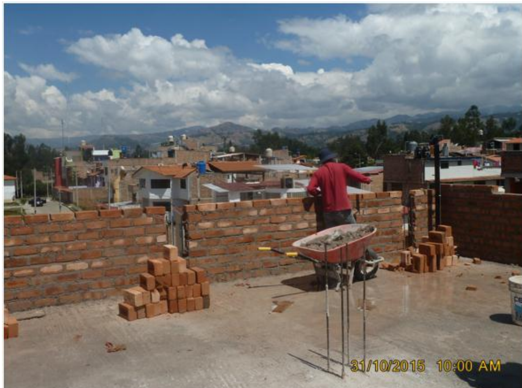
FOTOGRAFÍA N° 19: Muro construido hasta las 8 va fila con uso del escaniplo.
