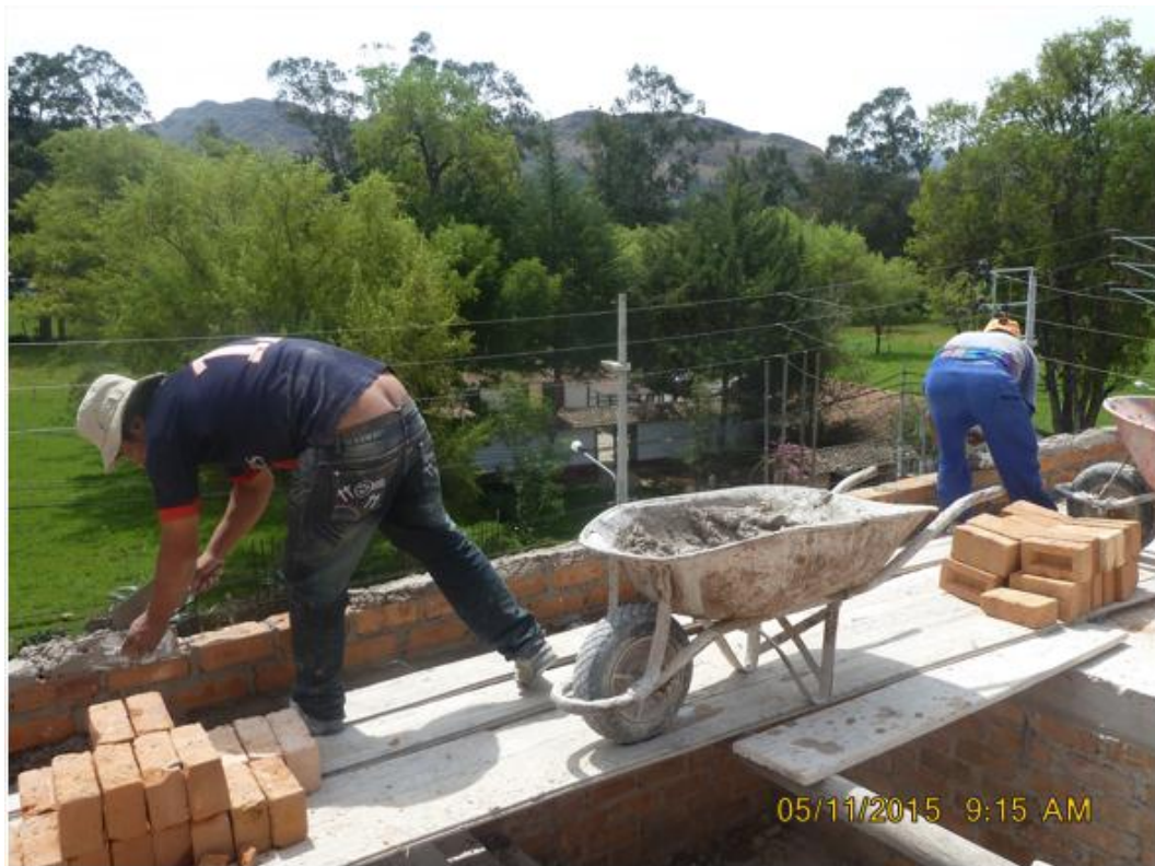
FOTOGRAFÍA N° 23: Muro de albañilería construido hasta la 7 ma fila.
