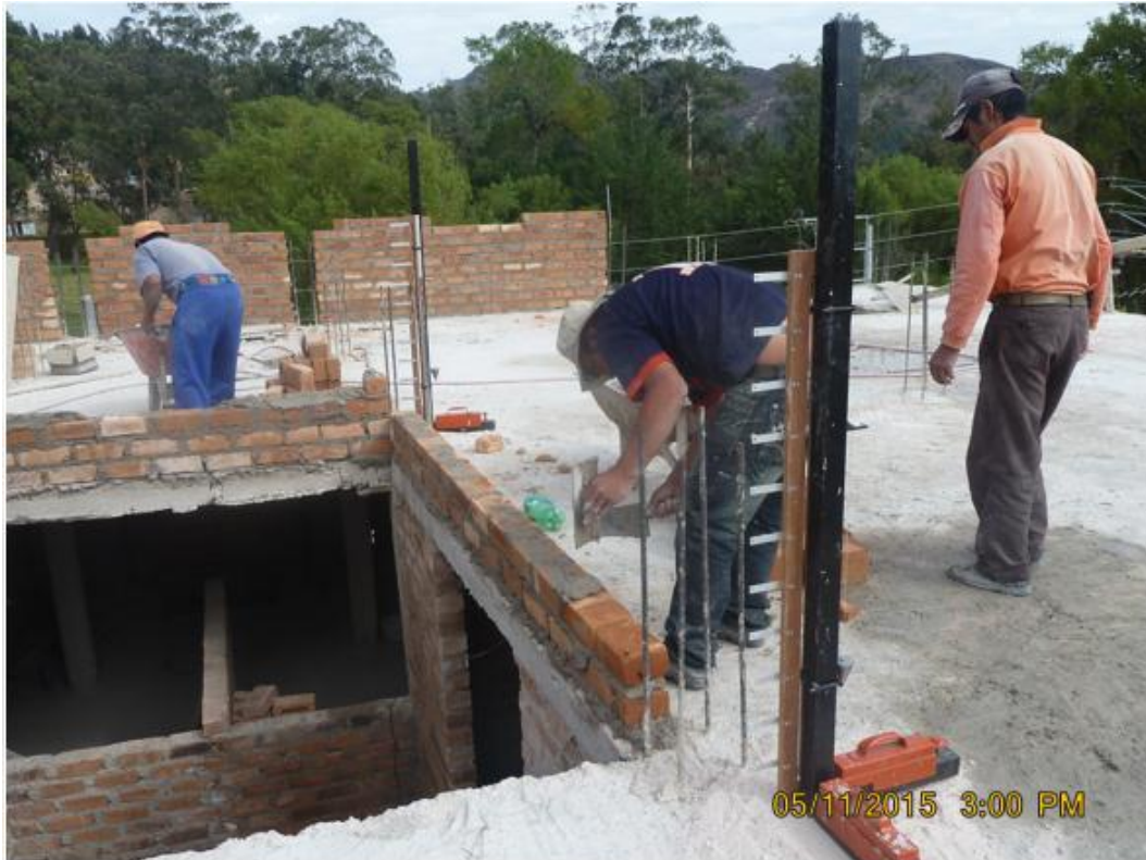
FOTOGRAFÍA N° 26: Construcción de murete de albañilería usando el escaniplo.
