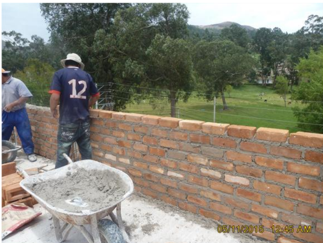
FOTOGRAFÍA N° 25: Muro de albañilería construido hasta la 8 va fila.
