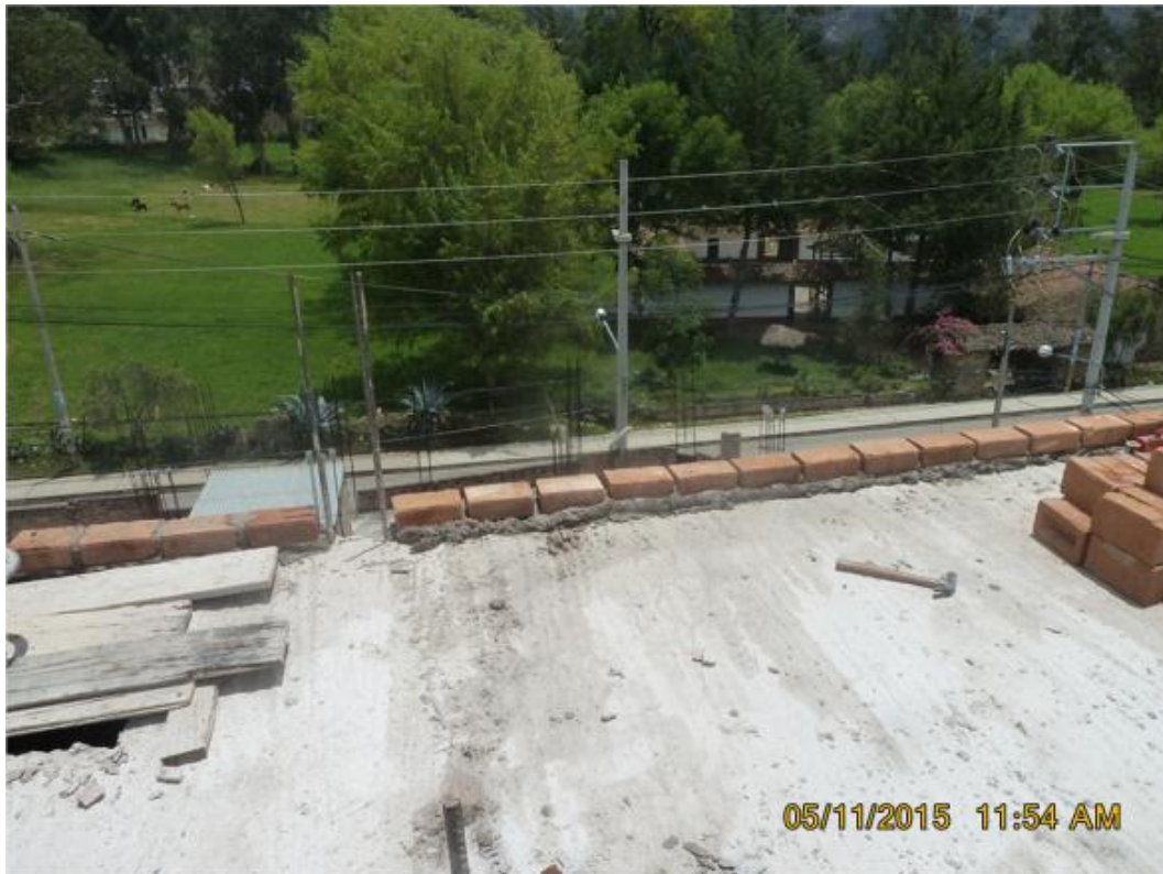
FOTOGRAFÍA N° 24: Emplantillado del muro sin el uso del escaniplo.
