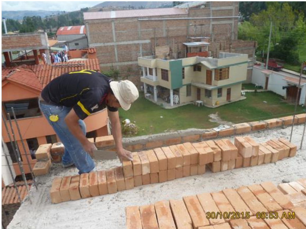
FOTOGRAFÍA N° 14: Colocación de la unidad de albañilería.
