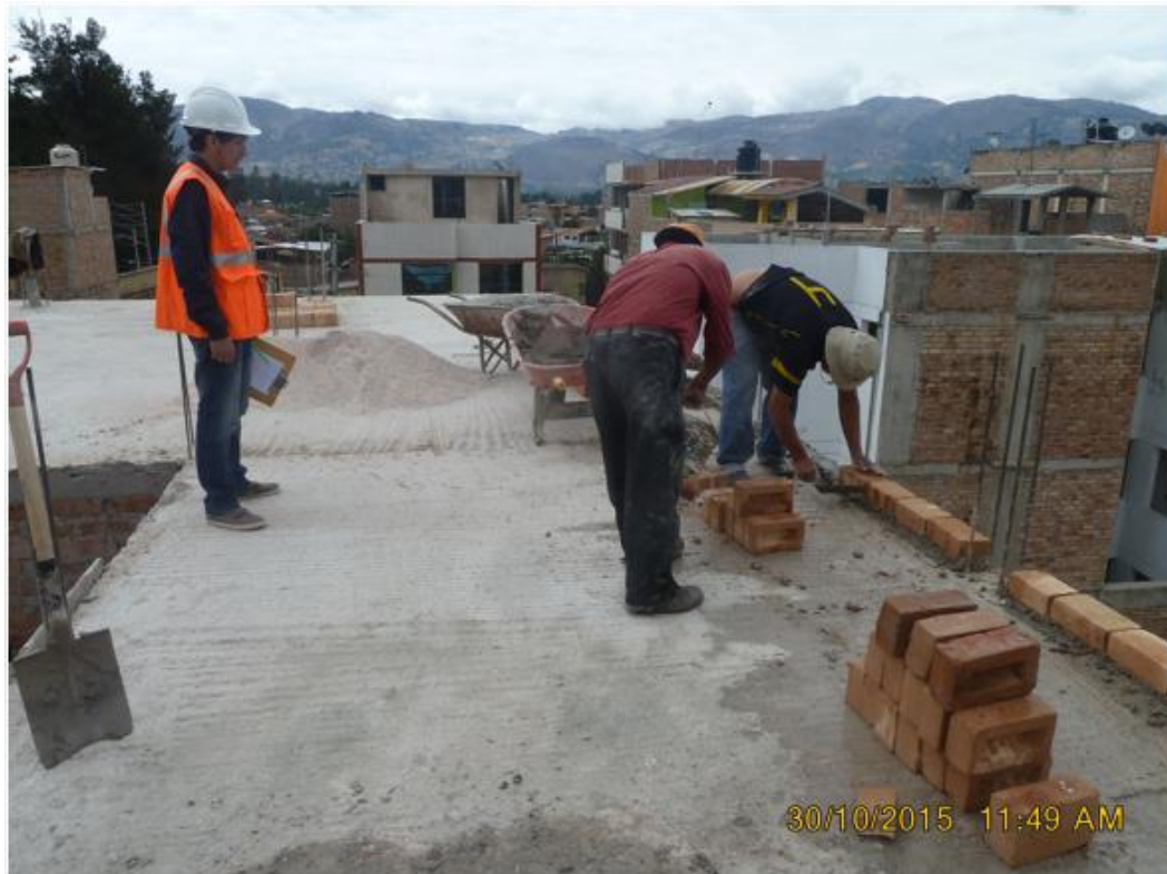
FOTOGRAFÍA N° 16: Construcción del Muro de albañilería sin uso del escaniplo.
