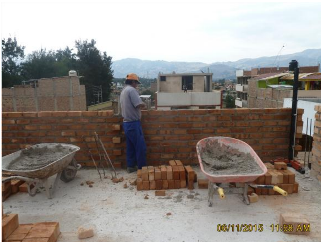
FOTOGRAFÍA N° 29: Muro construido hasta la 8 va fila con uso del escaniplo
