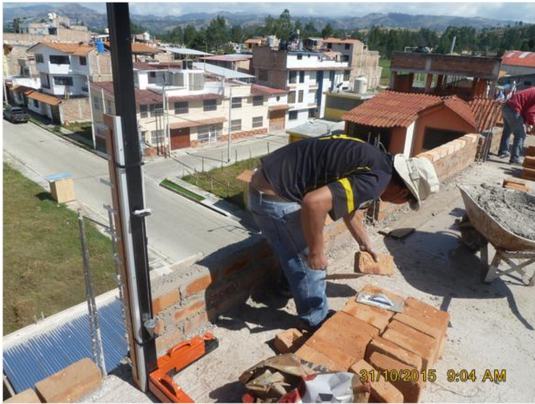
FOTOGRAFÍA N° 18: Construcción del muro de albañilería usando el Escaniplo.
