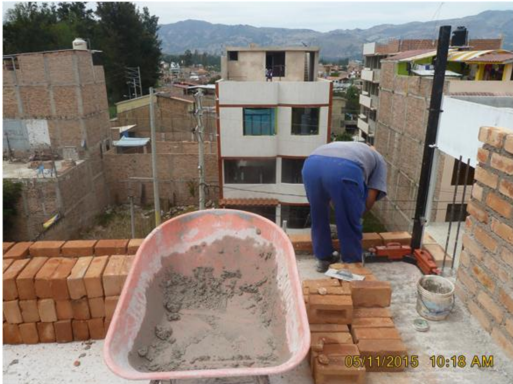
FOTOGRAFÍA N° 29: Muro construido hasta la 8 va fila con uso del escaniplo
