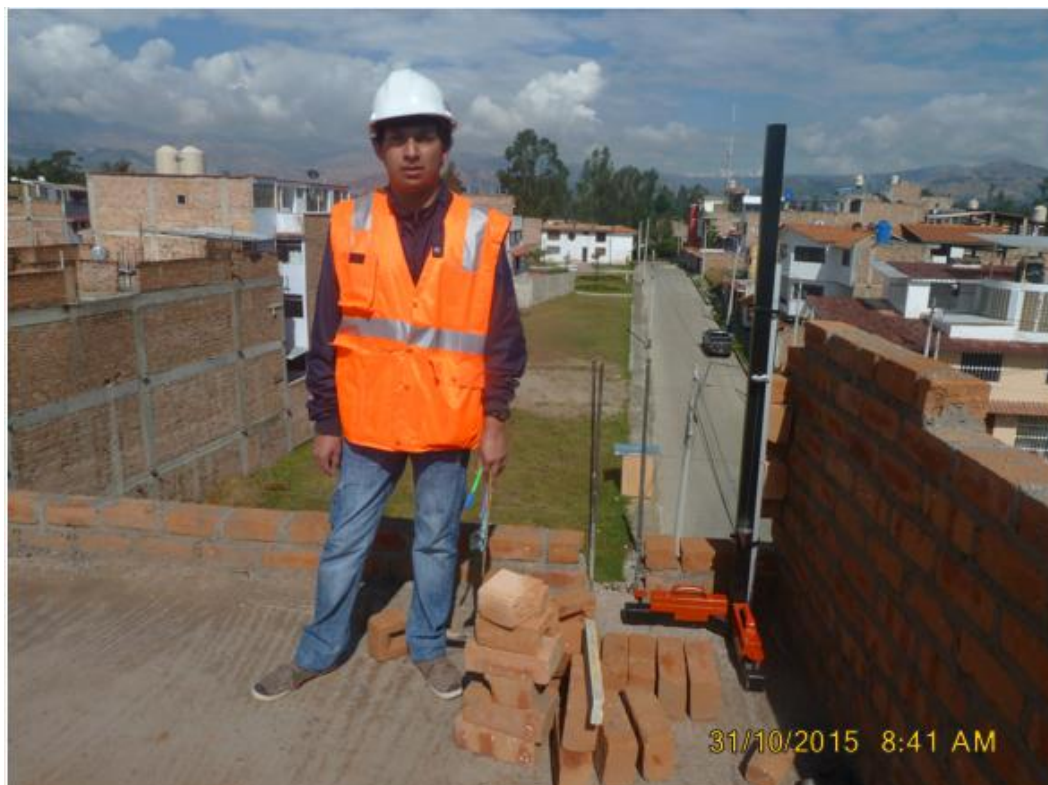
FOTOGRAFÍA N° 17: Escaniplo correctamente ubicado y aplomado.
