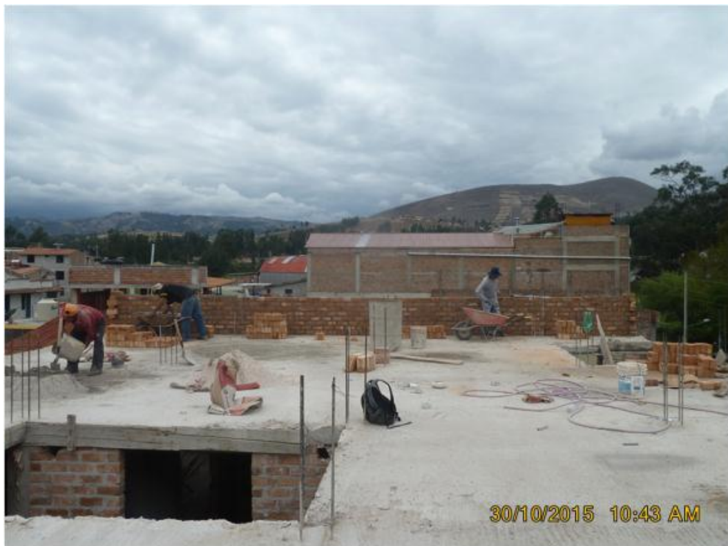
FOTOGRAFÍA N° 15: Muro en 8 va fila con mano de obra tradicional.
