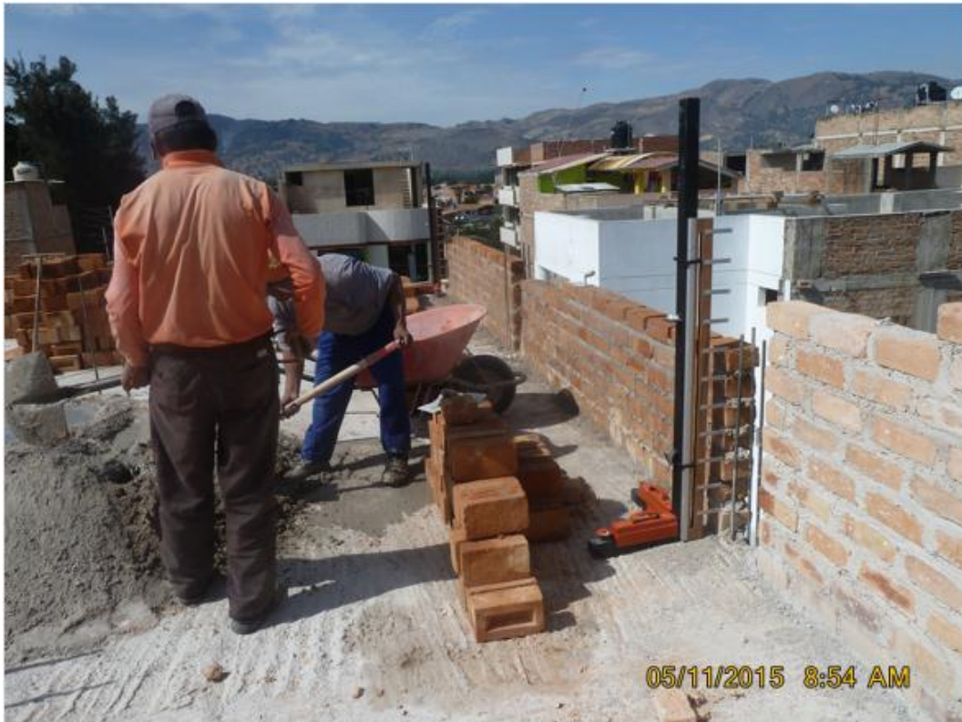
FOTOGRAFÍA N° 20: Preparación de la mezcla de mortero.
