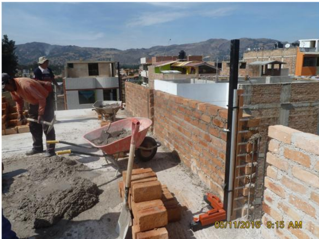
FOTOGRAFÍA N° 21: Muro construido hasta la 9 na fila con el uso del escaniplo.
