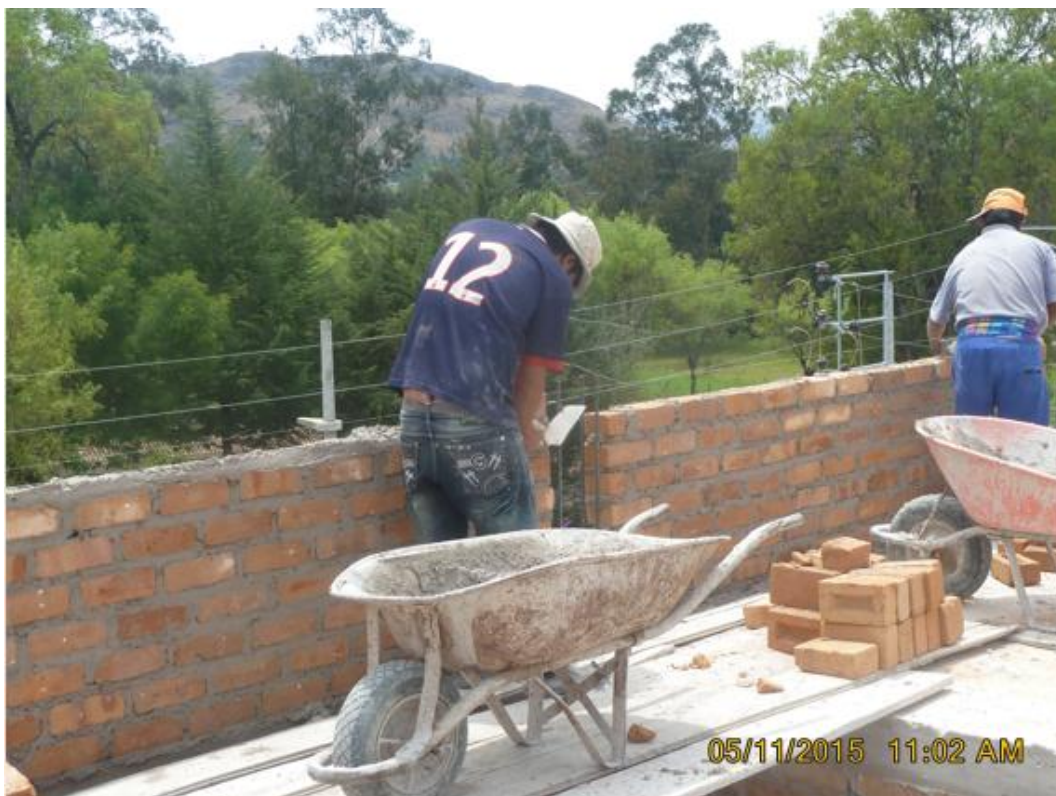
FOTOGRAFÍA N° 23: Muro de albañilería construido hasta la 7 ma fila.
