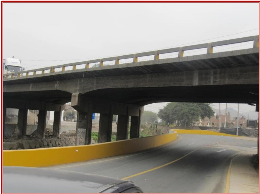
*Figura 15:* Vigas longitudinales y transversales del puente Chillón
