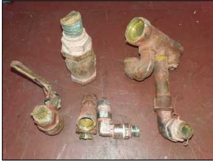
Figura n°. 3-14. Piezas hidráulicas dañadas y obstruidas, por uso de agua dura.
