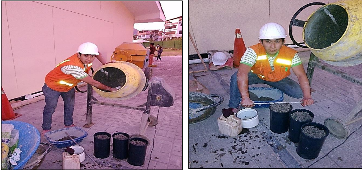
Fotografía 09: Elaboración del concreto permeable
