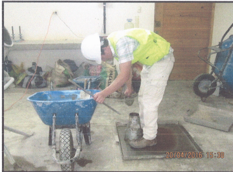
Foto n°31: Ensayo de asentamiento del concreto, para verificar si la mezcla está cumpliendo con el diseño elaborado.
