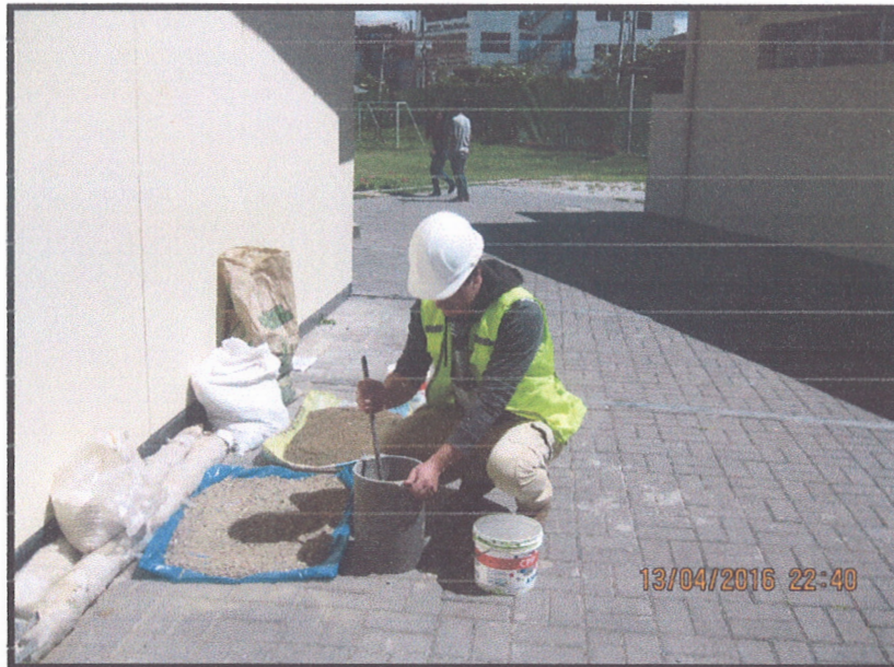
Foto n°03: ensayo para calcular el peso unitario seco compactado del agregado fino
