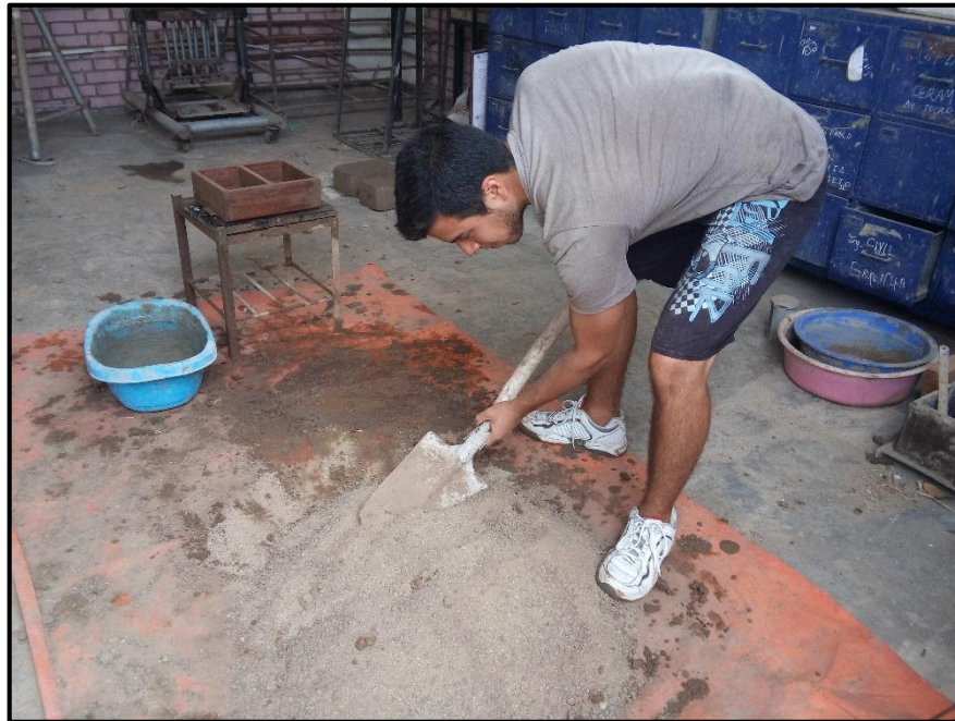
Figura 6.10: Elaboración de mezcla para los adobes
