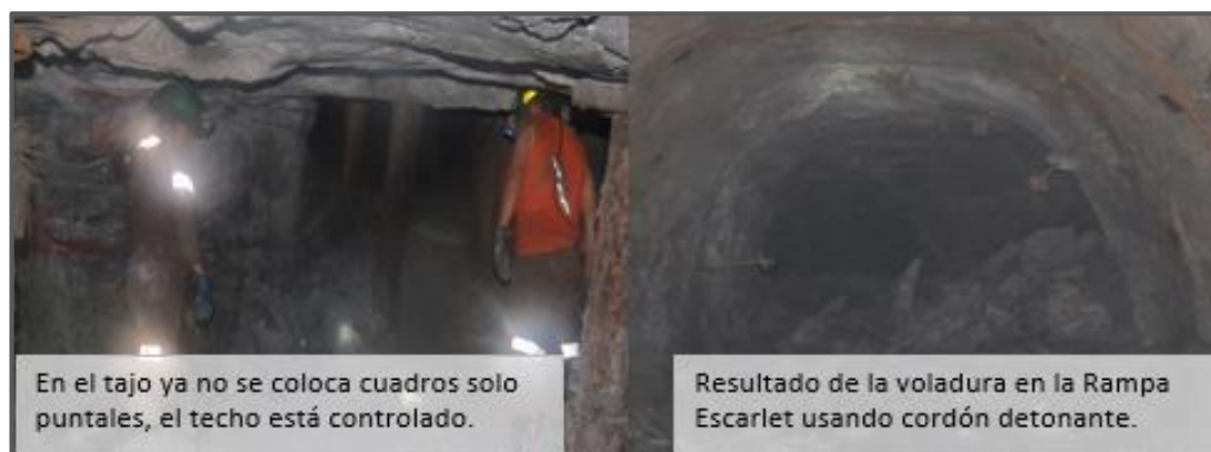
Figura N° 39 – Resultados de la voladura controlada
