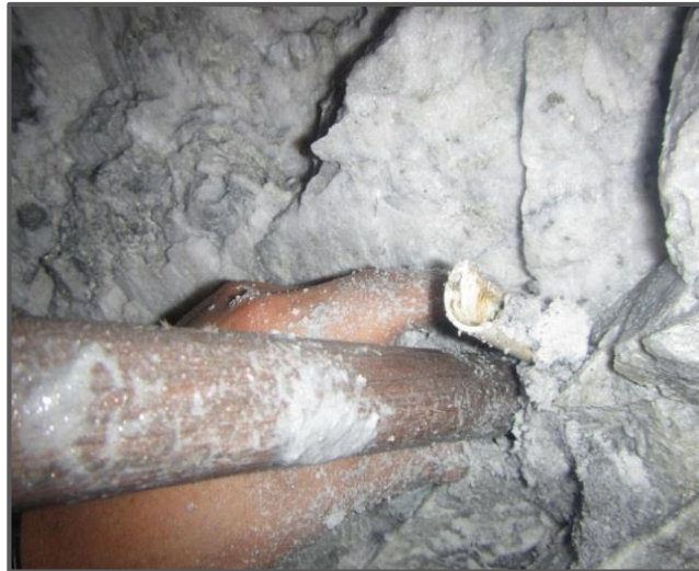
Figura N° 35 – Preparación de Taco Inerte
