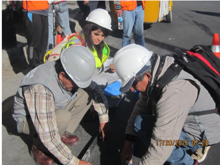
Figura N°. 39: Armado de la viga Benkelman
