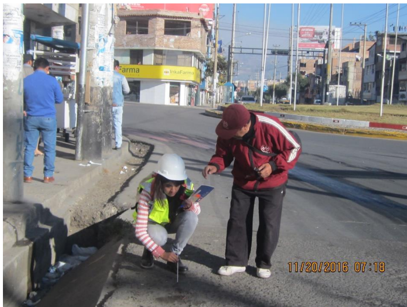
Figura N°. 38: Tomando la temperatura del Pavimento
