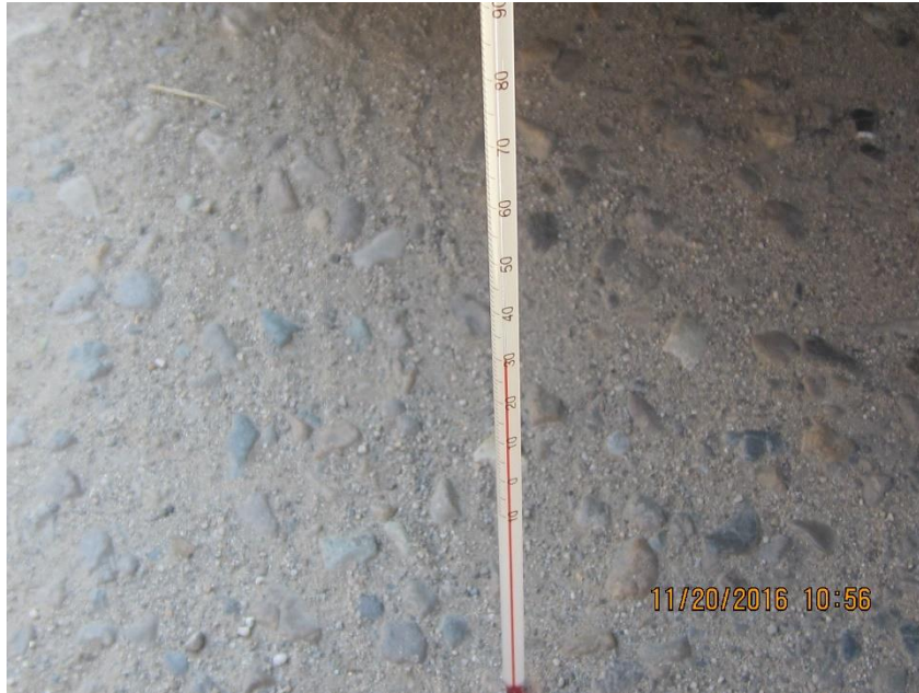
Figura N°. 45: Temperatura del Pavimento
