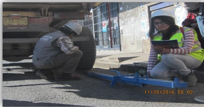
Figura N°. 5: Equipo Viga Benkelman instalado para efectuar las mediciones de las deformaciones
