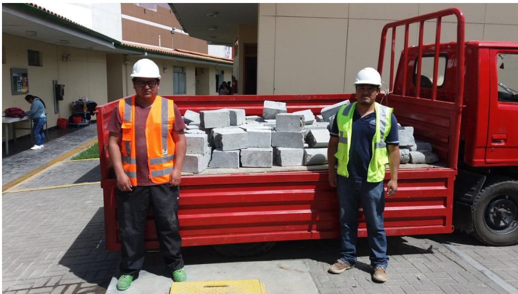
Fotografía N° 42: Eliminación de desmonte
