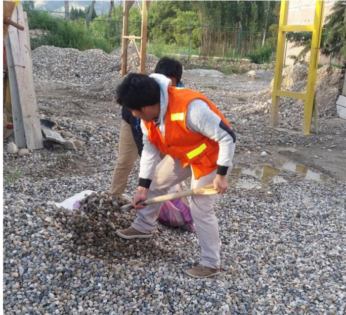
Fotografía N°2: Obtención de agregados – cantera rio Mashcón
