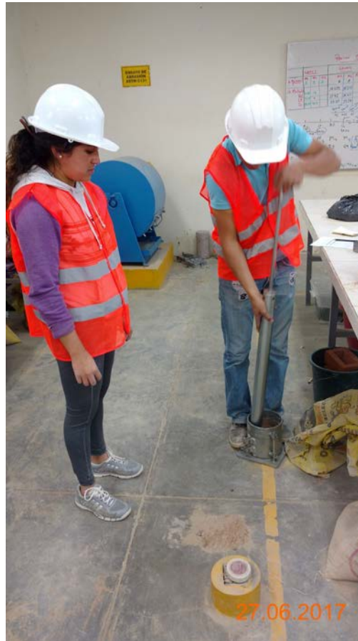
Foto 13. Ensayo de compactación.
