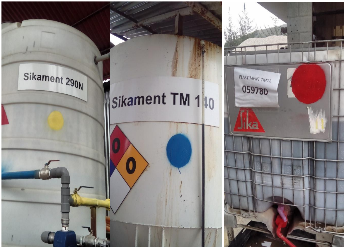
Figura n.º 48: Tanques de Almacenamiento de Aditivos.
