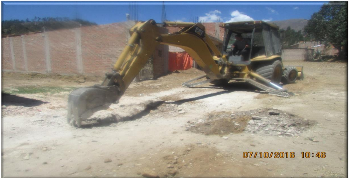
Figura n° 2: Inspección visual de la calicata N° 04
