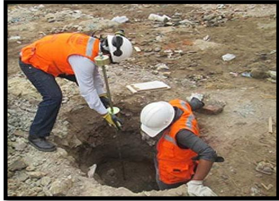
PERSONAL LABORANDO EN LA CALICATA
