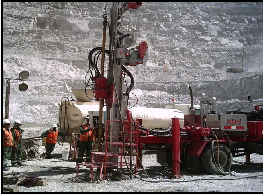
Figura N° 3. Equipo de perforación
