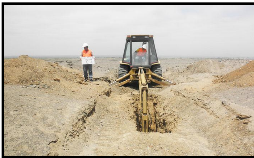
Figura N° 1 Excavación para la calicata
