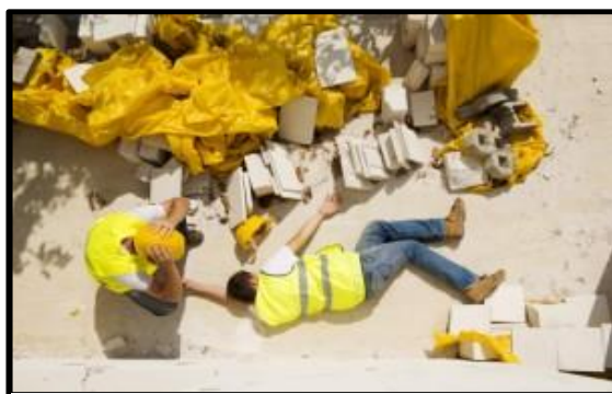
Figura n° 2.3 Accidente Fatal Fuente: Manual de prevención de riesgos laborales
