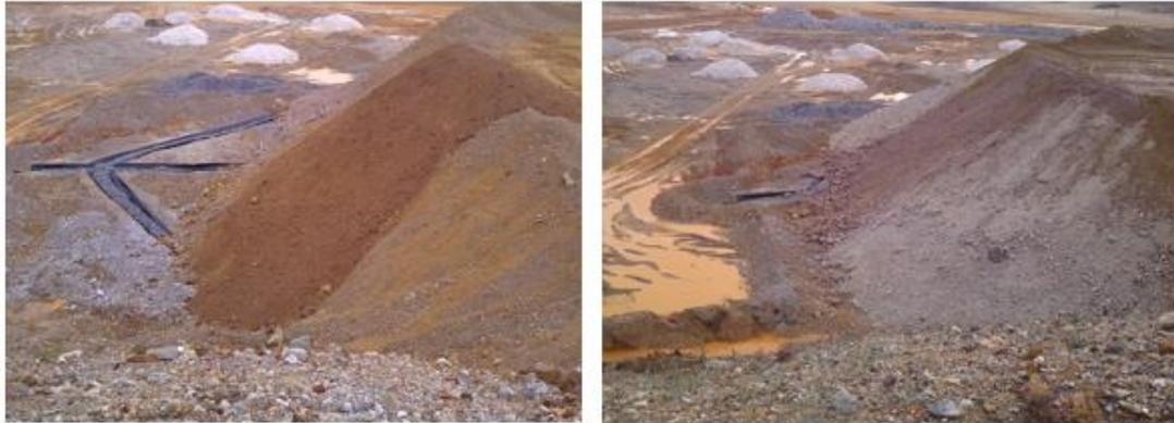
Fig. 10: Fotografía mostrando la acumulación de material en bancos de 8 m.
