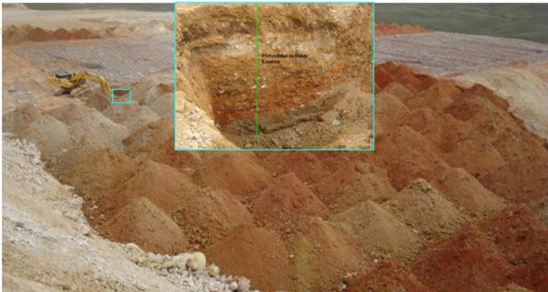
Fig. 03: fotografía mostrando la profundidad de batido 5m en la celda prueba.
