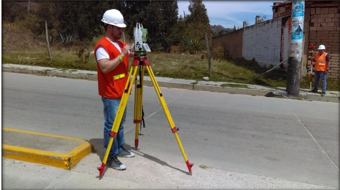
Programacion de estación total en punto de cambio.
