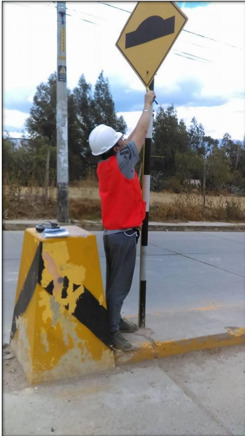
Medición de la altura en señal vertical
