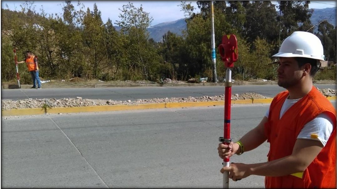
Toma de puntos de extremos de la calzada.
