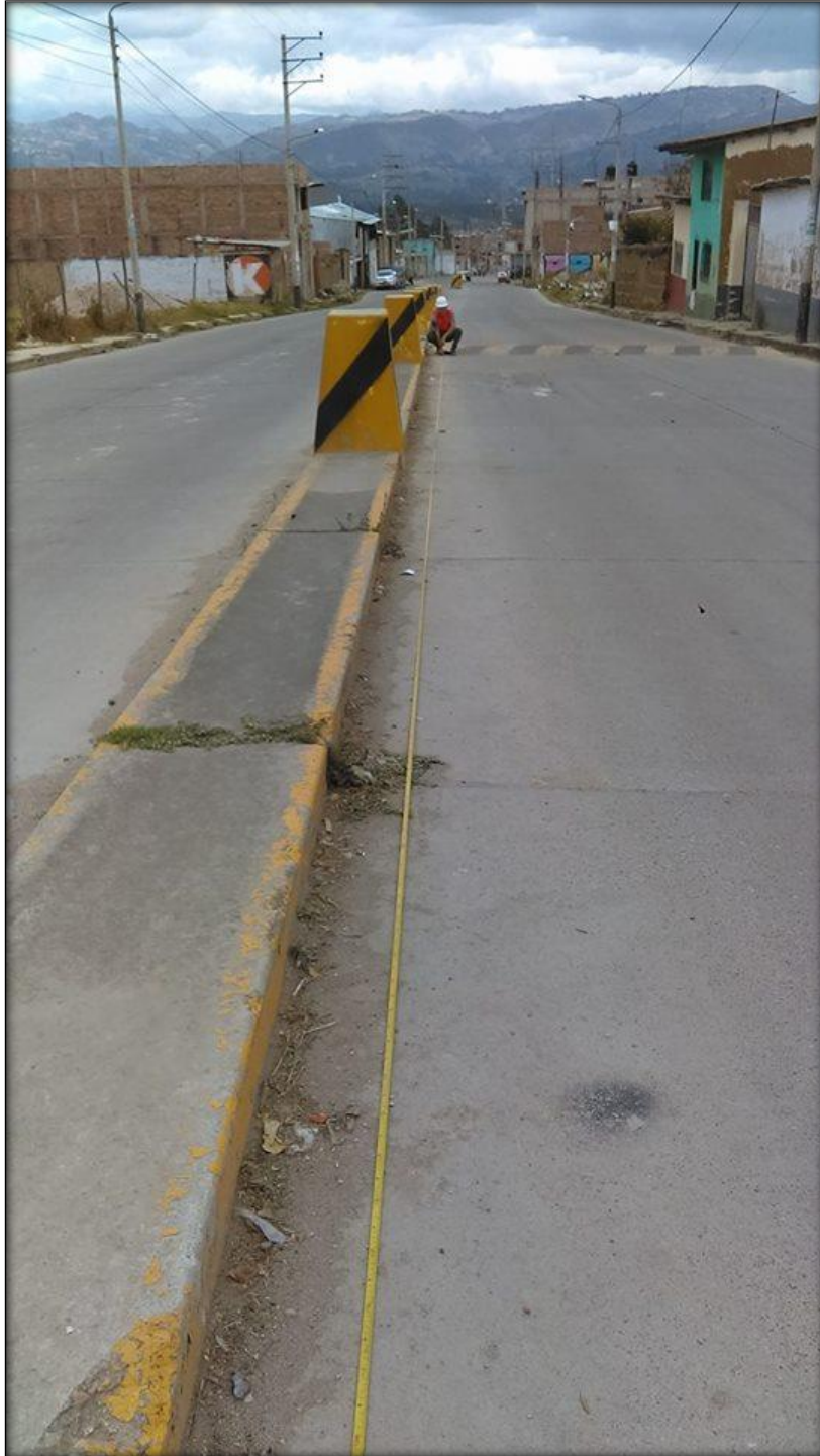
Medición longitudinal del dispositivo al sobresalto.
