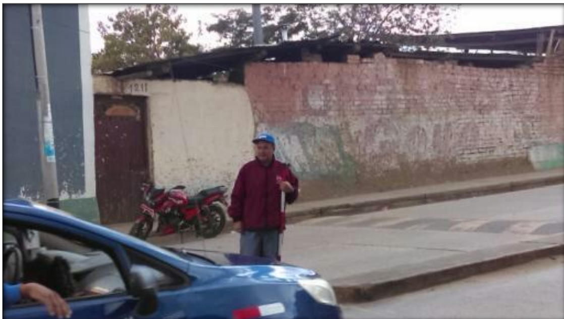
Asesor apoyando en la toma de punto en sardinel central.
