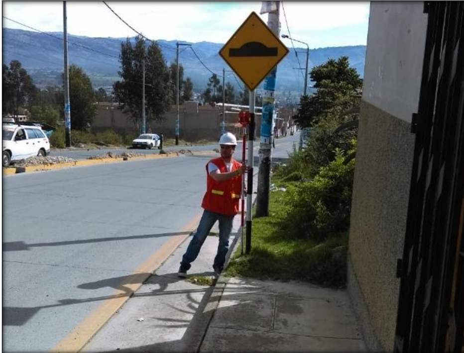
Toma de punto en señal de tránsito.
