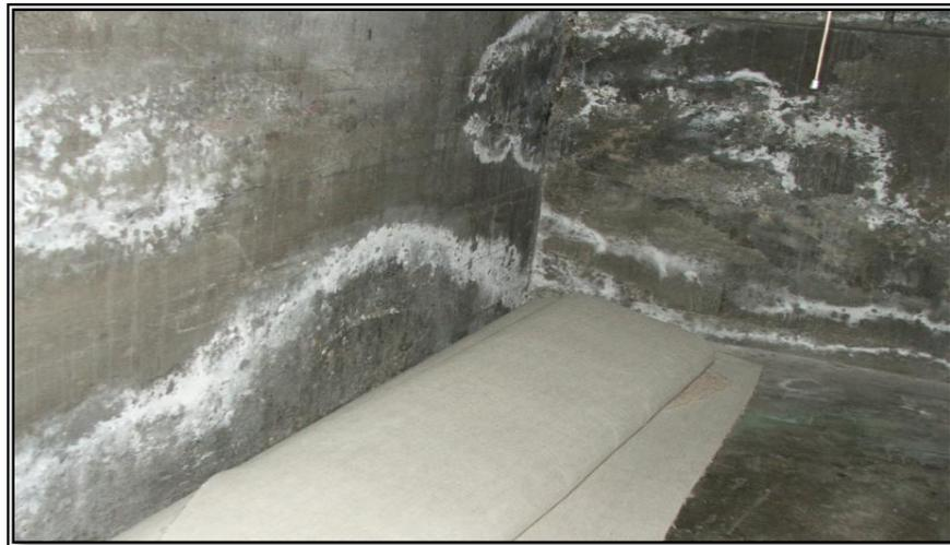
*Figura N° 7: Eflorescencia presente en paredes de concreto.*
