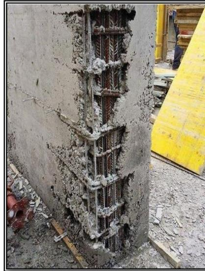
*Figura N° 67: Cangrejas en placa de concreto.*
