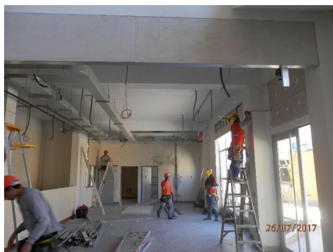
Trazo y Transporte de planchas de Superboard de 6mm
