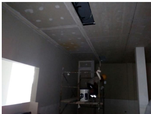
Masillado y empastado de FCR de Fibromineral de 6mm
