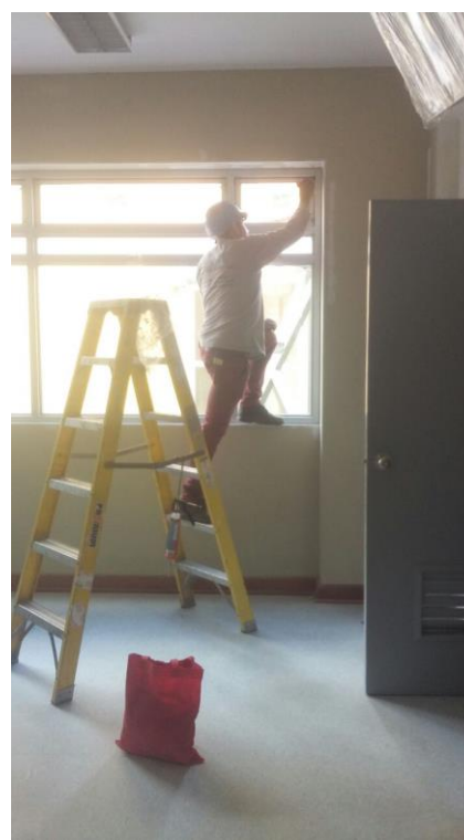
Colocación de Vidrios y Sellado de aristas
