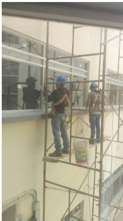
Colocación de Vidrios y Sellado de aristas
