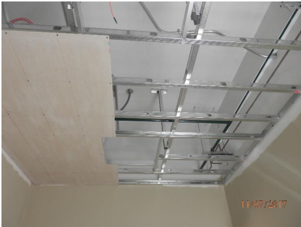
Colocación de las planchas de fibrocemento
