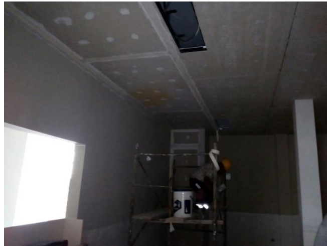
Transporte, armado y traslado de andamios
