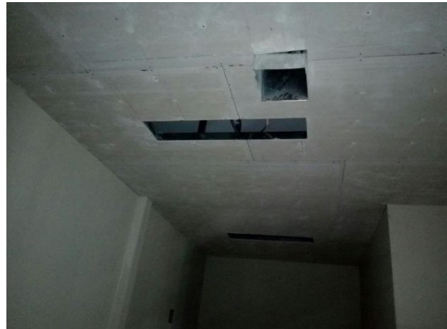
Colocación de las planchas de fibrocemento
