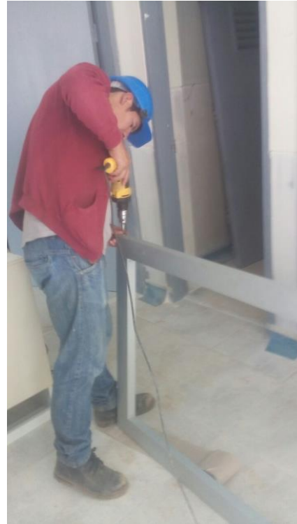
Ensamblaje de los marcos de las ventanas
