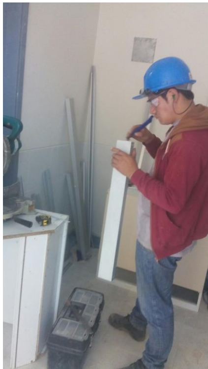
Ensamblaje de los marcos de las ventanas
