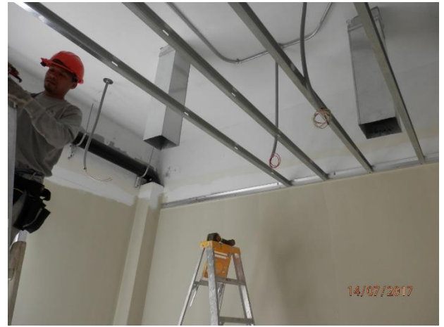
Armado de estructura para FCR de Superboard de 6mm
