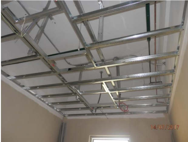
Armado de estructura para FCR de Superboard de 6mm
