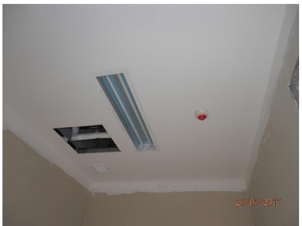
Masillado y empastado de FCR de Fibromineral de 6mm
