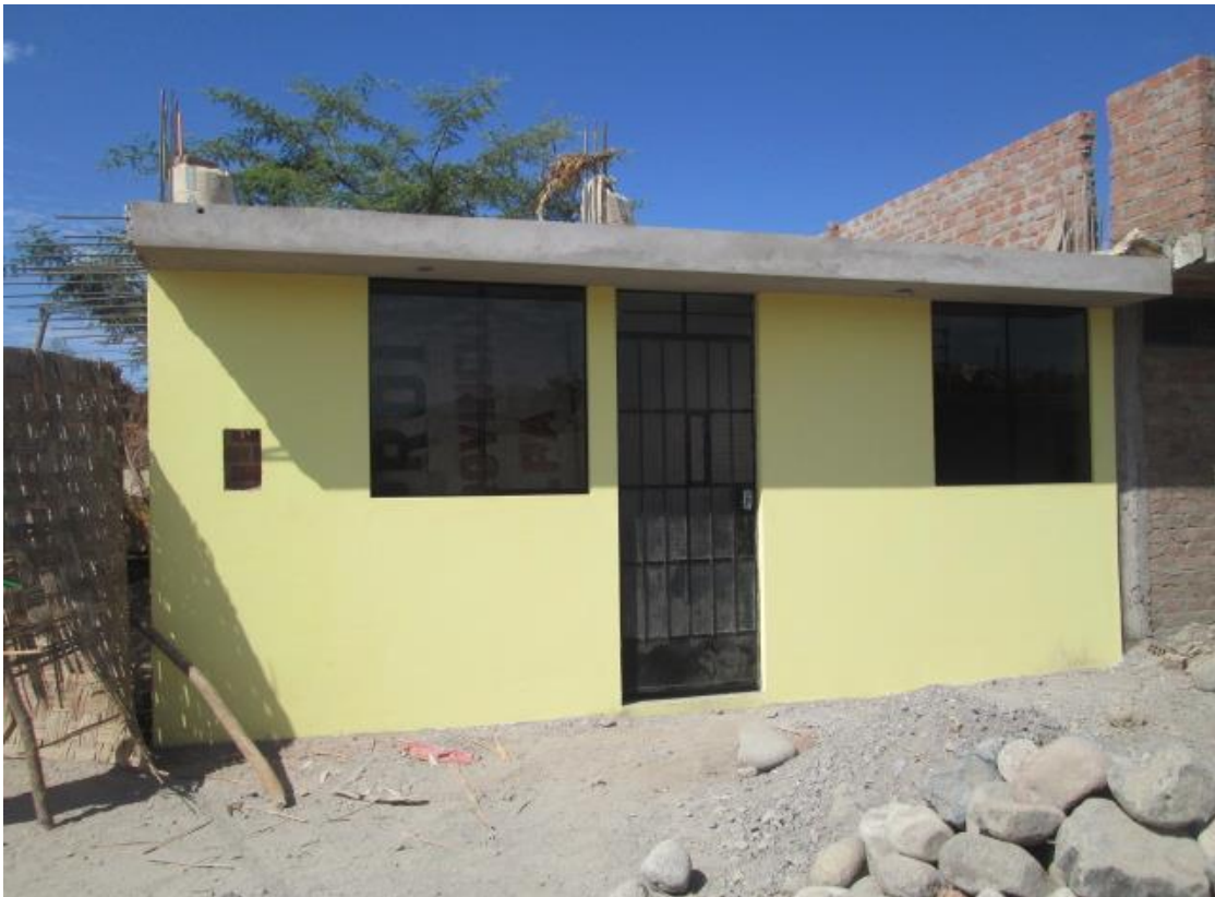
Figura 2. Vivienda Habitacional Terminada de 35 m 2 .
