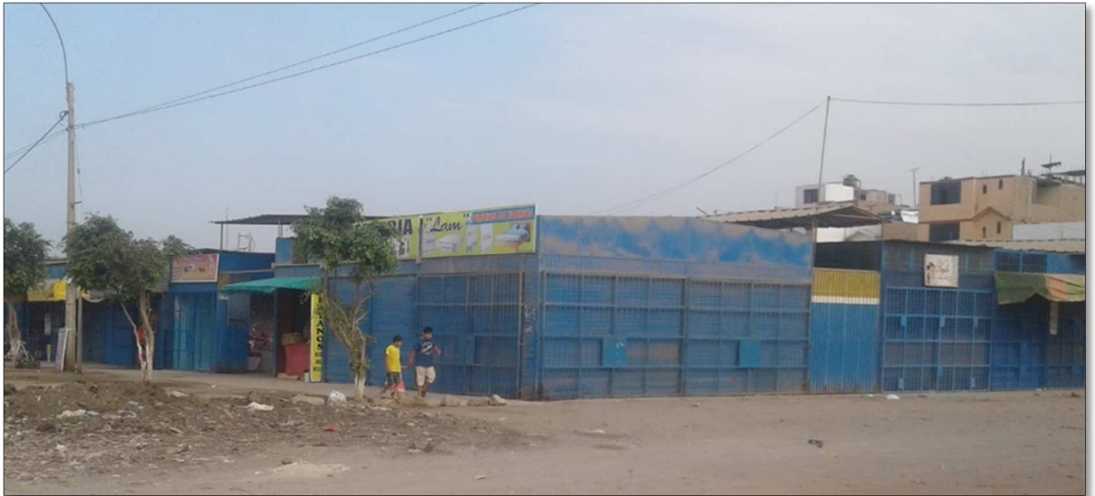
Figura n.º 6-3. Fotografía del Centro Comercial Sarita Colonia en el distrito de San Martin de Porres
