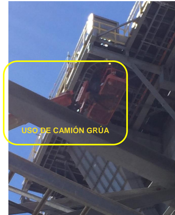
Figura 03. Uso de camión grúa para el tendido de cable
