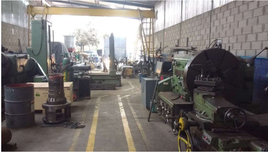
Figura 22 Área de Soldadura Fuente: Elaboración propia
