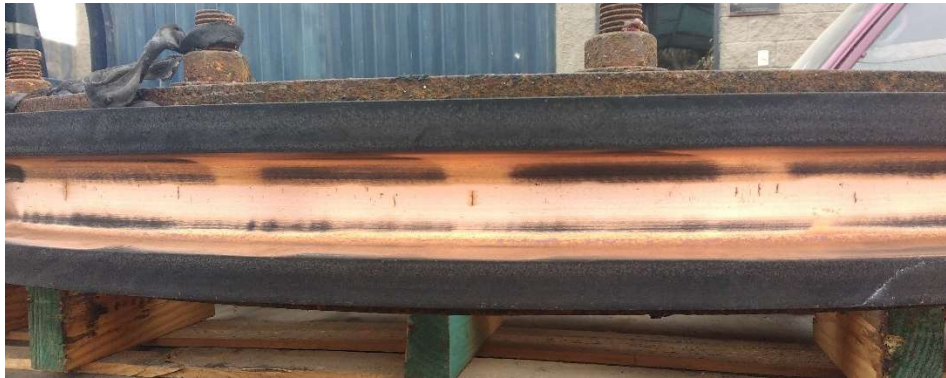
Detalle del canal con rajaduras
