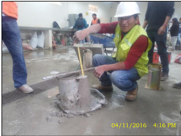
FOTO N° 13 Prueba de asentamiento del concreto de 3" – 4"
