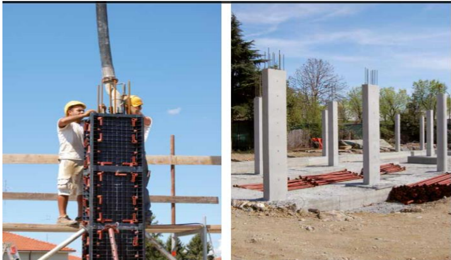
Figura N° 40: Encofrado plástico en columnas rectangulares vs Encofrado tradicional
