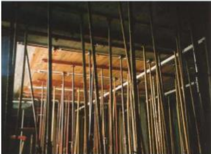
Figura N° 2: Encofrado de losa
