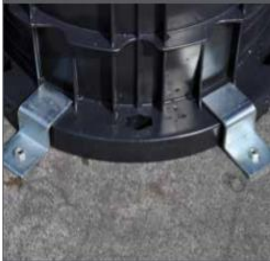
Figura 25: Fisaje al suelo en geo panel
