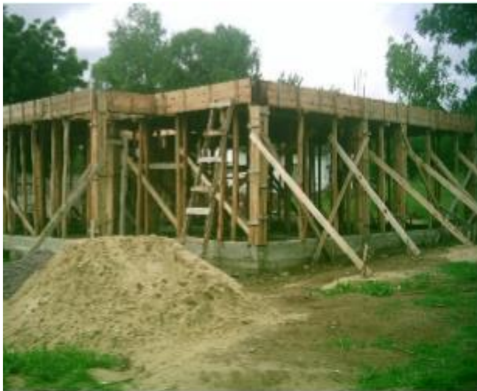
Figura N° 9: Encofrado de madera
