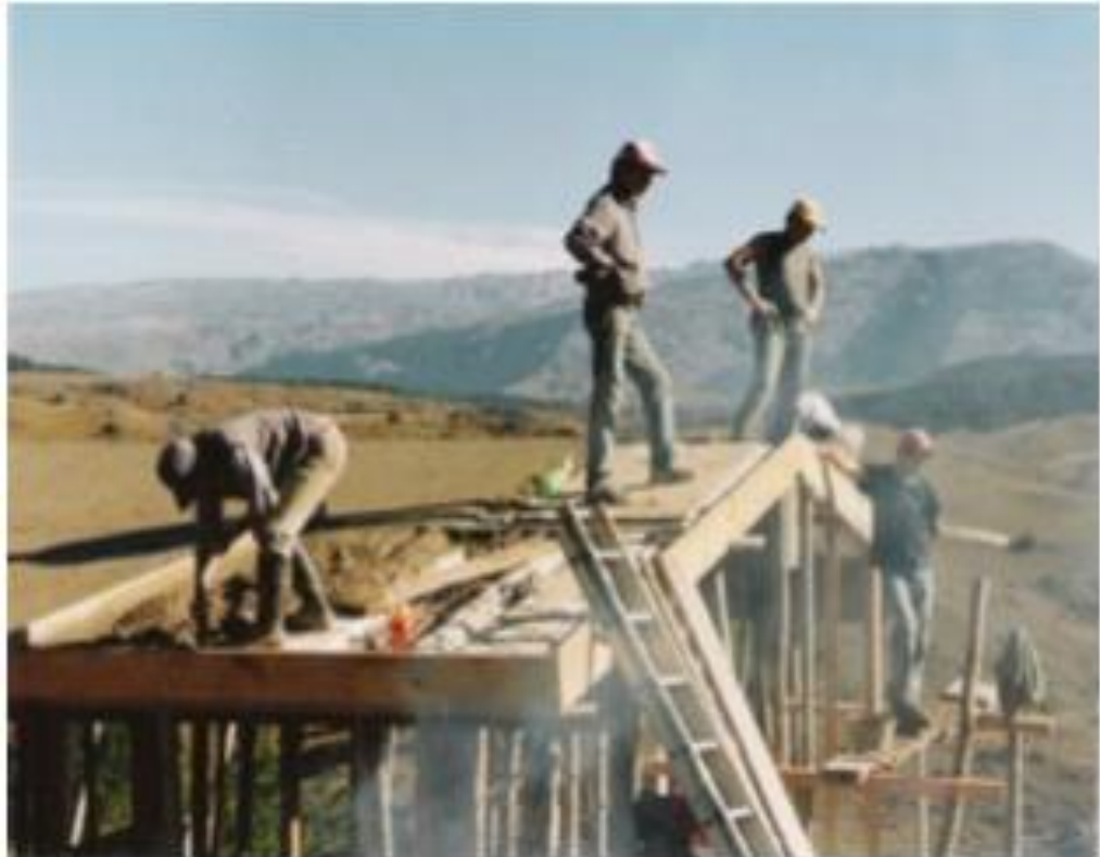
Figura N° 3: Cargas de Construcción
