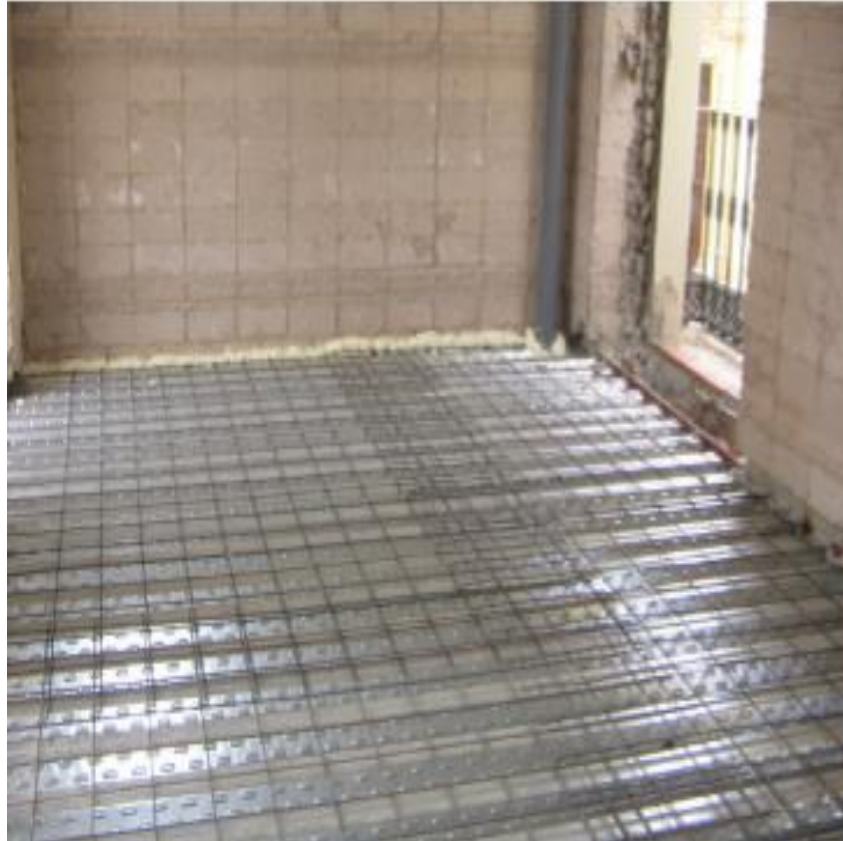
Figura N° 12:Encofrado perdido
