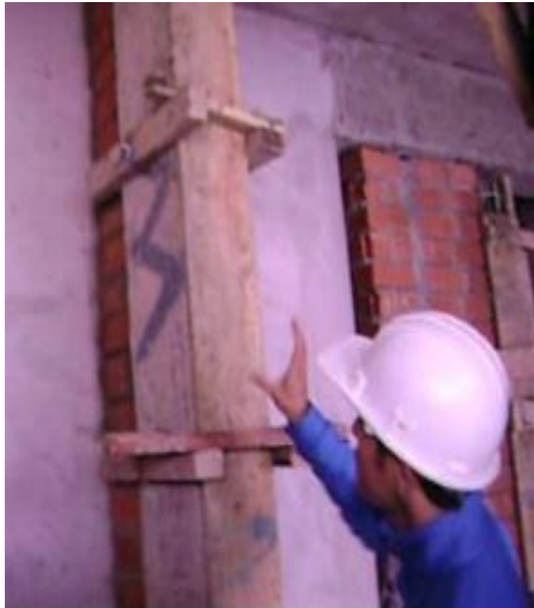
Figura N° 1: Encofrado en columna
