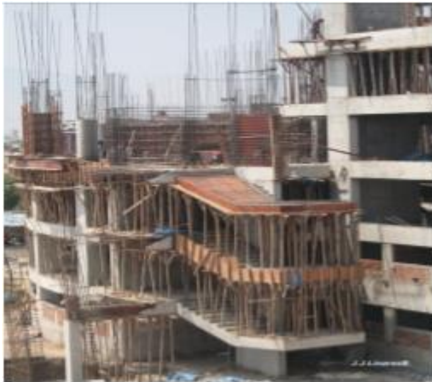
Figura N° 10: encofrado tradicional
