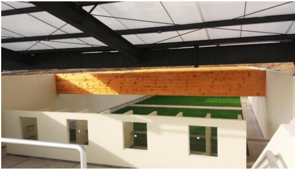
Figura N° 45: Ambiente polígono de tiro terminado
