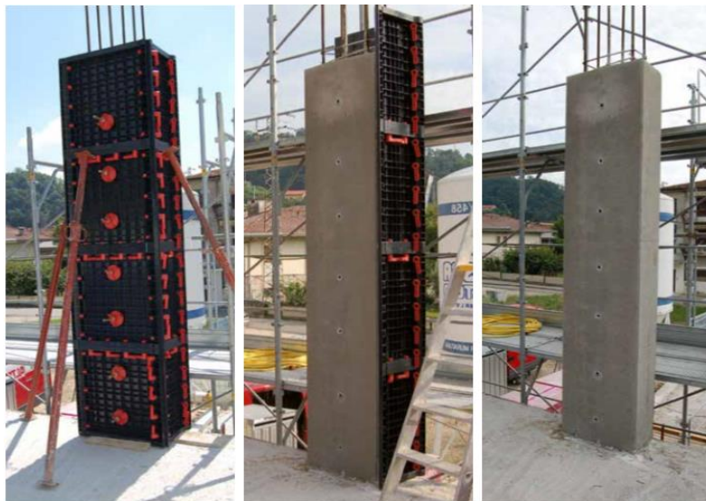
Figura N° 35: Encofrados Geotub en columnas cuadradas y rectangulares
