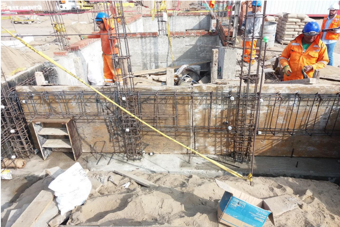
Figura N° 56 Colocación de acero para columnas
