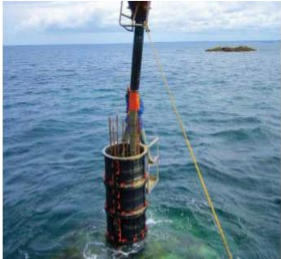
Figura N° 21: Columna circular Geotub en el mar
