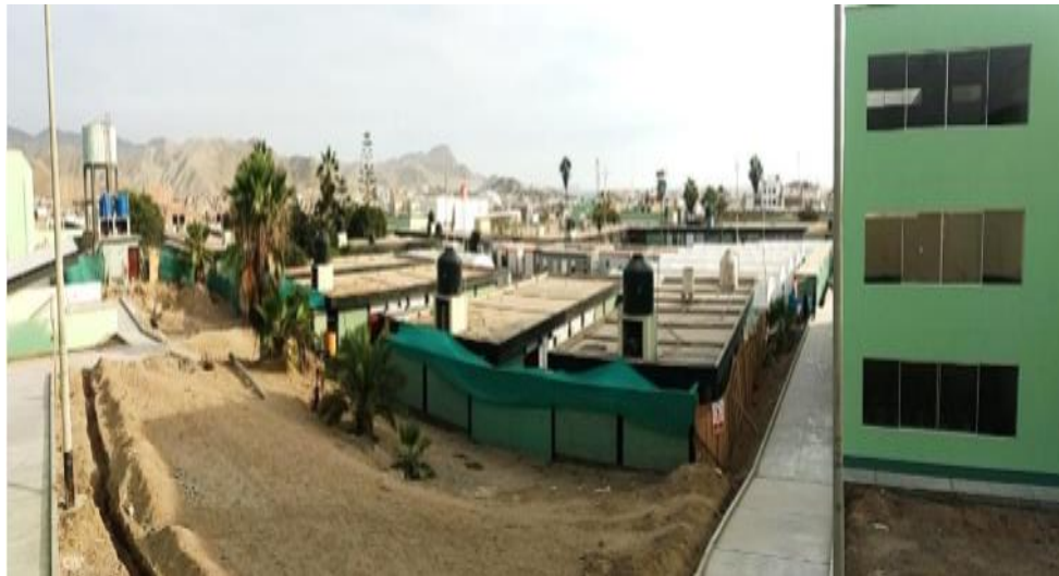
Figura N° 44: Vista panorámica obra culminada
