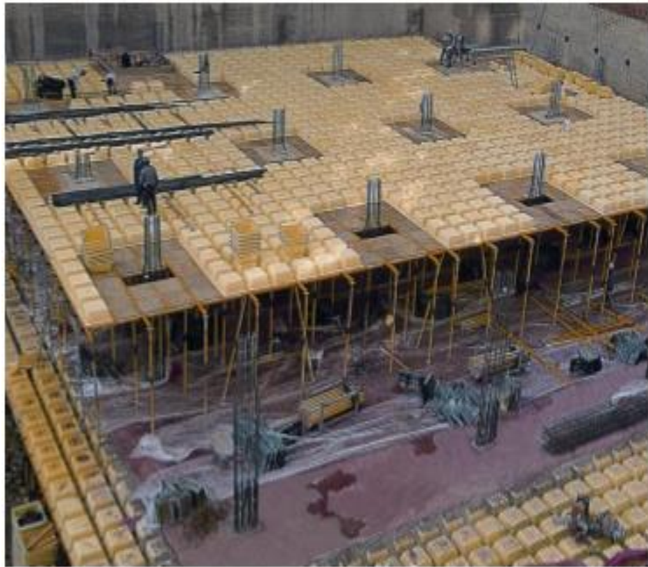
Figura N° 11: Encofrado recuperable
