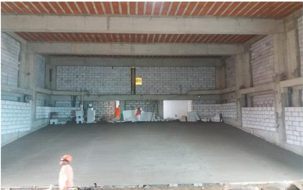
Figura N° 51: Acabado de vigas para auditorio
