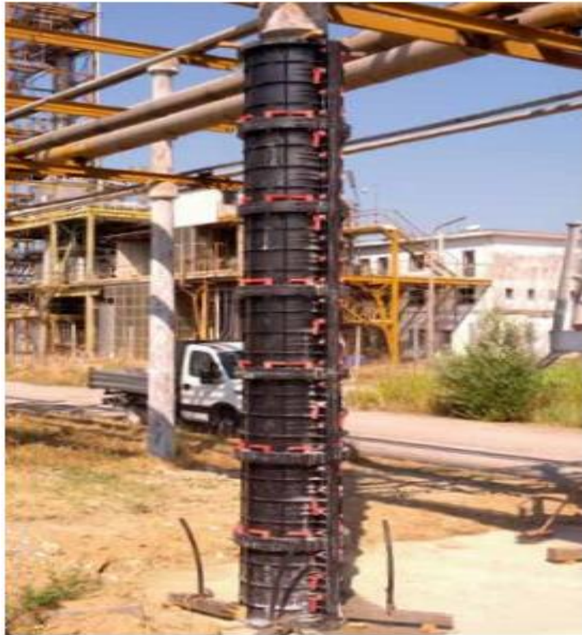
Figura N° 22: Columna circular Geotub
