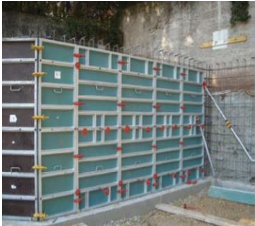
Figura N° 13: Encofrados plásticos
