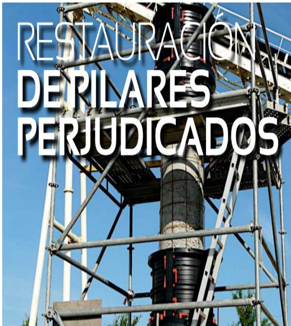
Figura N° 23: Pilares perjudicados restaurados con Geotub
