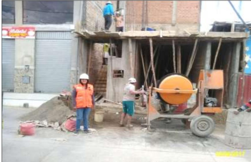
**FOTO 7 - Encofrado de losa aligerada - Vivienda 02**
