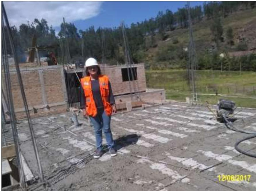
**FOTO 12 - Encofrado de losa aligerada - Vivienda 04**
