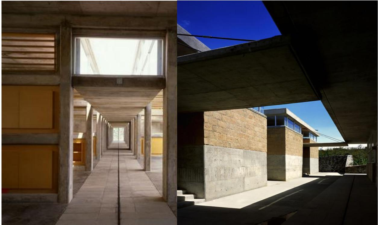
En el tercer filtro se repiten los materiales de concreto y tepetate buscando aislar las aulas del conjunto para luego abrirlas con cristales hacia los taludes y patios. En la biblioteca y gimnasio, la estructura híbrida del concreto con el acero, permite tener plantas libres, ininterrumpidas generando una continuidad con la plaza principal y el interior del edificio.
