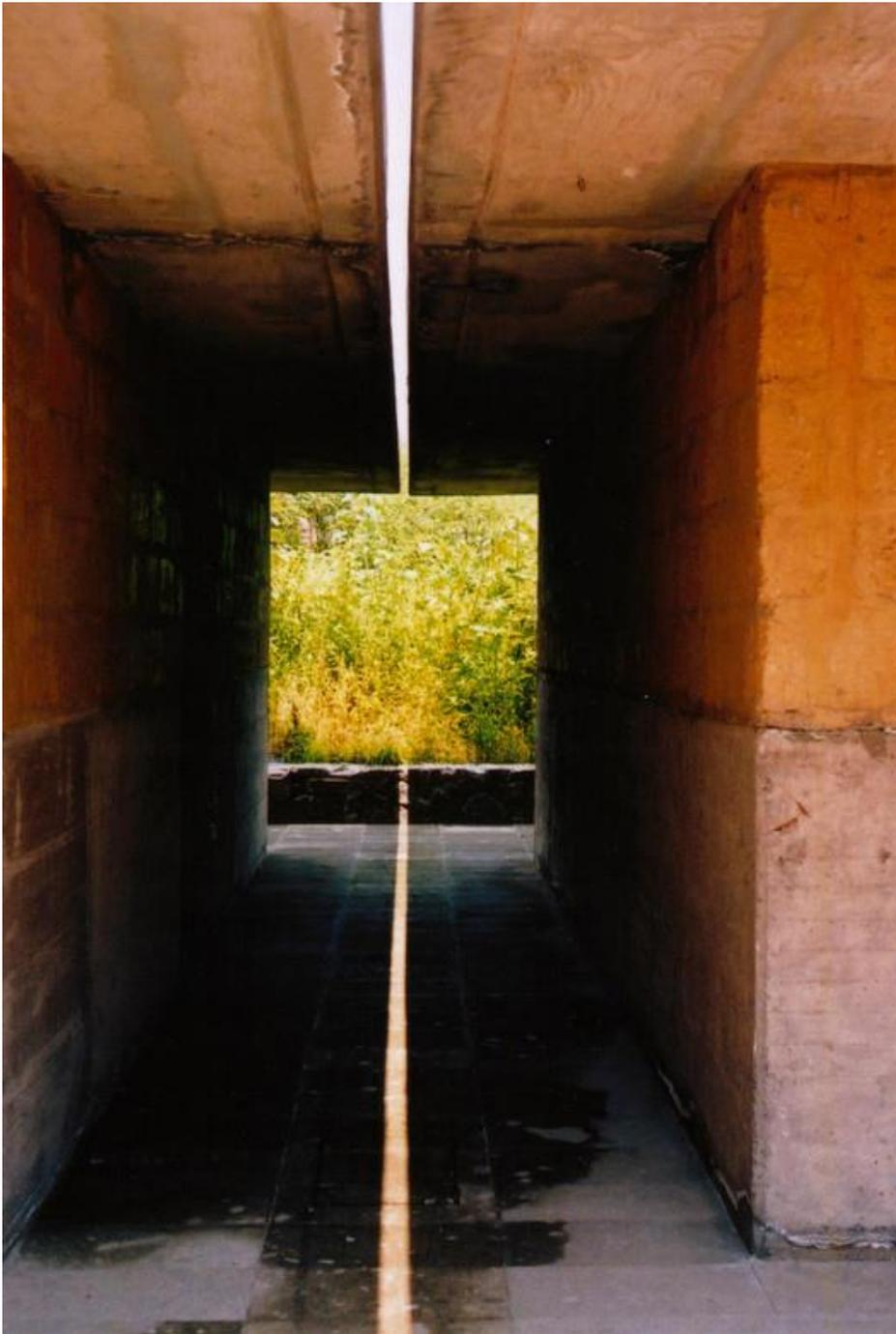
En la segunda zona, los edificios son más sólidos, muros de tepetate sobre un basamento de concreto, siendo los accesos las únicas aperturas junto con una banda horizontal de cristal entre el muro y la losa, circunstancia que limita la relación visual al exterior manteniendo una buena iluminación y la funcionalidad de las actividades que en estos se desarrollan. Sin embargo, en la tifloteca se sustituye el tepetate por cristal dándole carácter al edificio desde la plaza principal.
