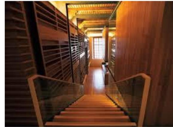
Las escaleras están recubiertas con láminas de madera dispuestas a modo de piso flotante, generando un foco de sonido, pero a modo más sutil, puesto que al ser método flotante, la cámara de aire al interior disminuye la intensidad del sonido.
