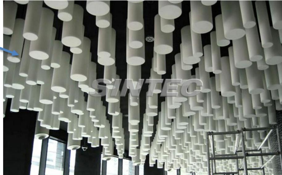
**Cilindros Absorbentes suspendidos en el techo:**
