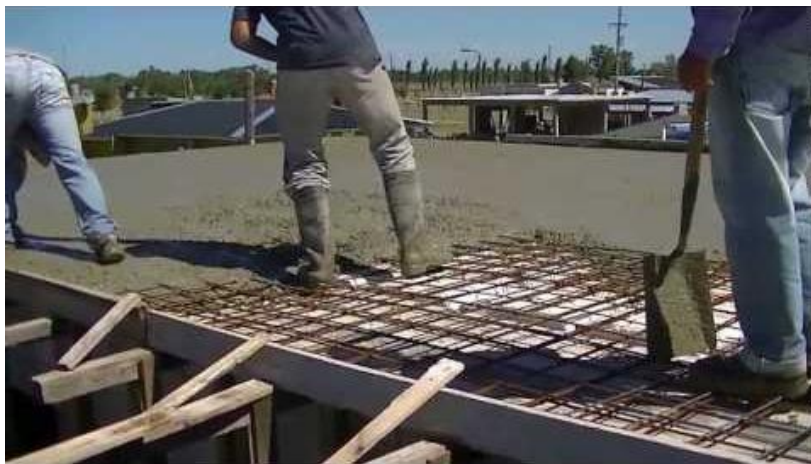
Figura 2: Vaciado de concreto para una losa en Urb. Santo Dominguito
