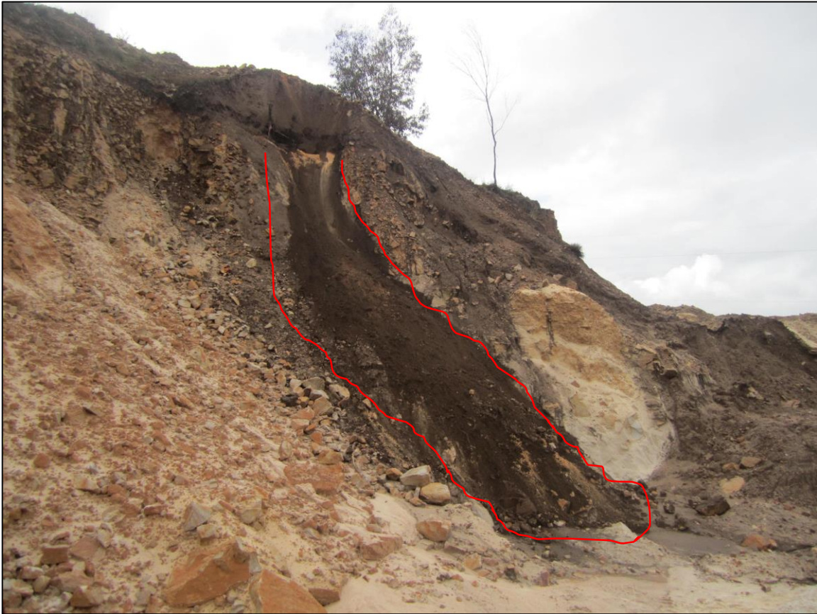
Figura 34: Deslizamientos por falta de estabilidad. Fuente: Elaboración propia, 2017.
