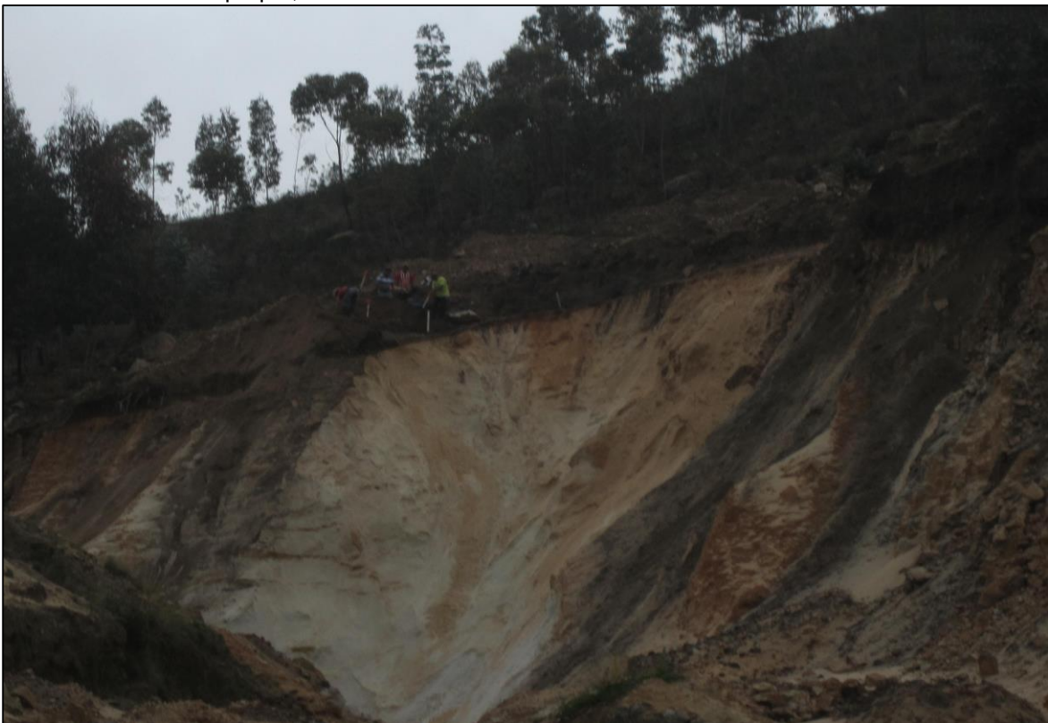
Figura 37: Limpieza de material orgánico. Fuente: Elaboración propia, 2017.
