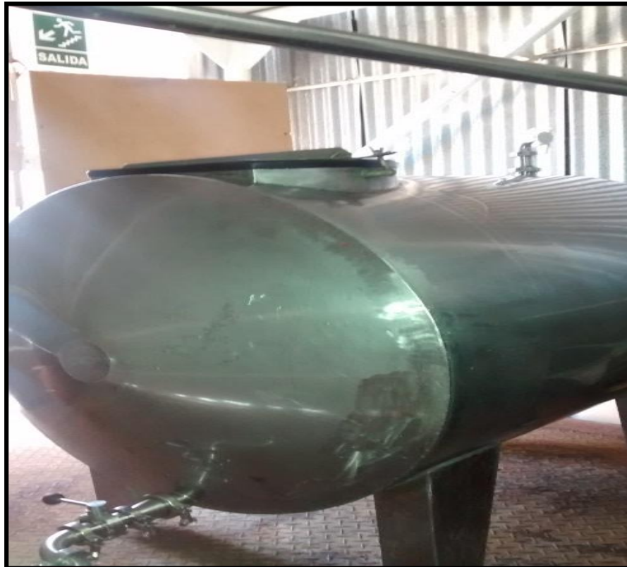
Fig. N°19: Sistema de enfriamiento.
