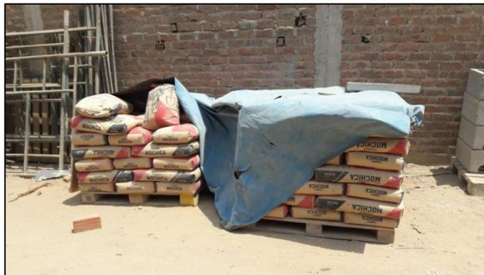
El área actual del ambiente es 345 m<sup>2</sup> (23mt largo x 15mt ancho), del cual se colocará techo a un área de 16.2m<sup>2</sup> para los materiales que requieren protección contra el sol y las lluvias, principalmente cemento, fierro y arena).
