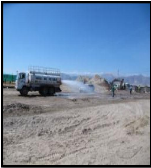
Registro fotográfico de la detección en campo de posibles No Conformidades.
