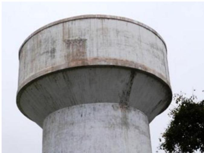
Figura 1: Filtración expuesta en reservorio (RPP)
