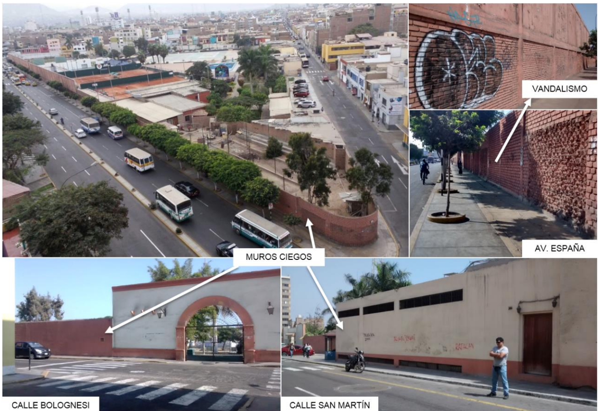
Figura N°14: Degradación del Área a Intervenir.
