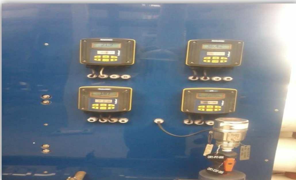
Figura 17. Analizador de Sílice y sensor de conductividad, PH, temperatura, transmisor de presión
