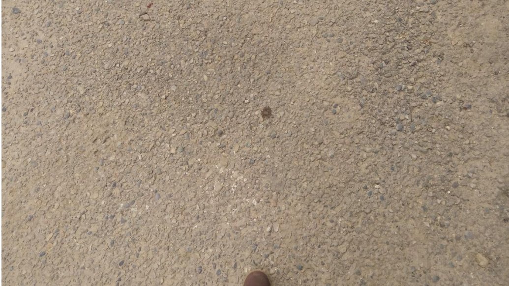
UM - 02. Meteorización / Desprendimiento de Agregados (Nivel de Severidad: Bajo “L”, Medio “M”)
