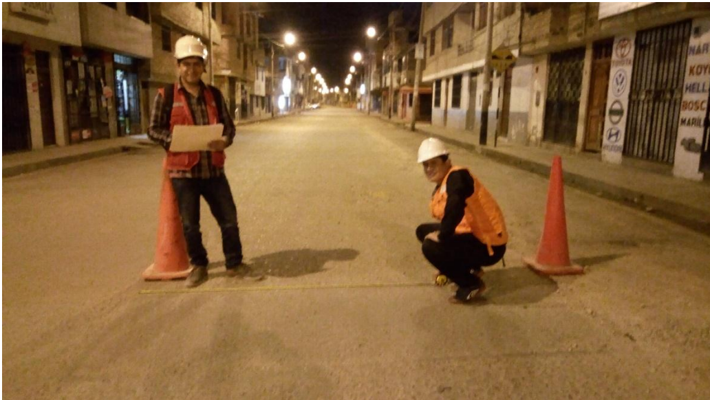
UM - 01. Parcheo Acometidas De Servicios Públicos (Nivel de Severidad: Bajo "L", Medio "M")
