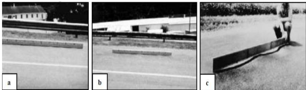
Figura N° 6: Corrugación. Bajo (a), Medio (b) y Alto (c).
