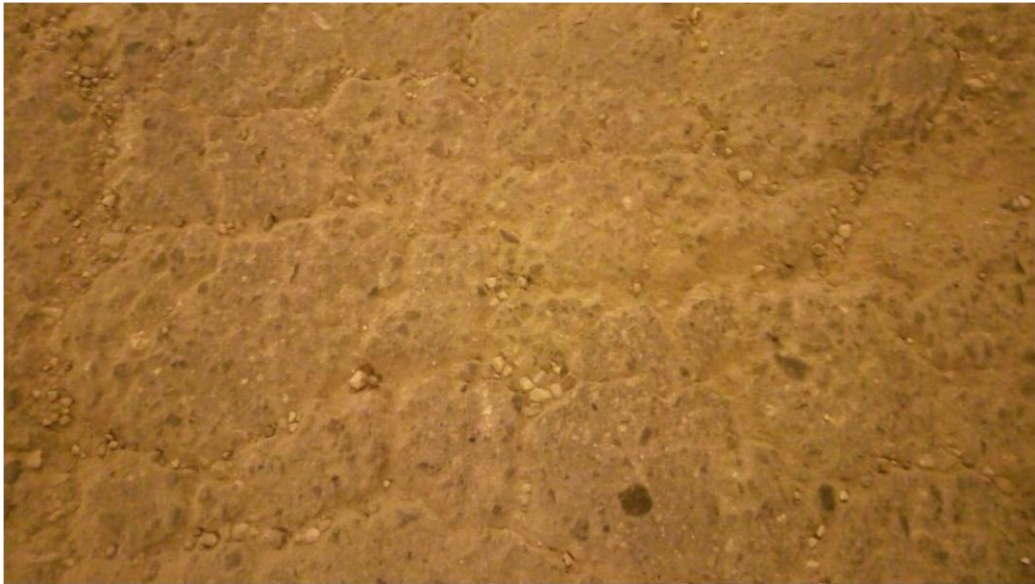
UM - 01. Piel de Cocodilo (Nivel de Severidad: Medio “M”)
