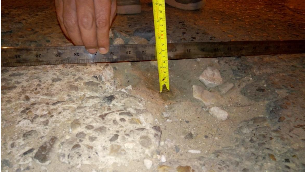
UM - 01. Huecos (Nivel de Severidad: Bajo “L”, Medio “M”)
