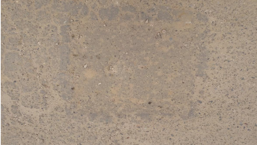
UM - 01. Parqueo Acometidas De Servicios Públicos (Nivel de Severidad: Bajo "L", Medio "M")
