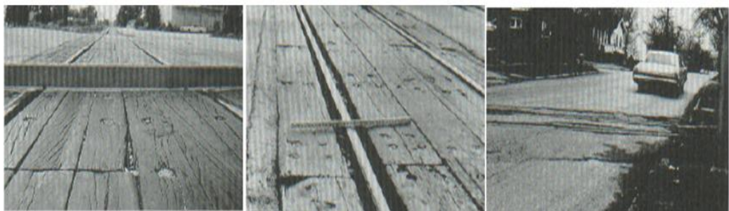
Figura N° 16: Cruce de vía férrea. Bajo (a), Medio (b) y Alto (c).
