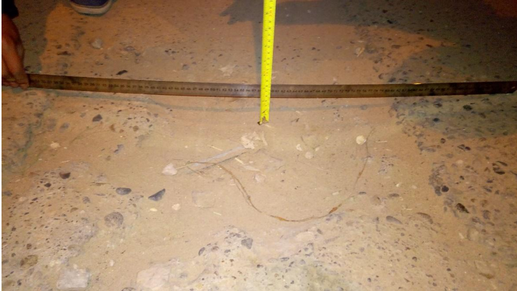
UM - 07. Huecos (Nivel de Severidad: Bajo "L", Medio "M")
