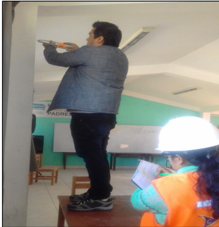
FOTO N° 27: Realizando el ensayo de esclerometría parte superior de columna
