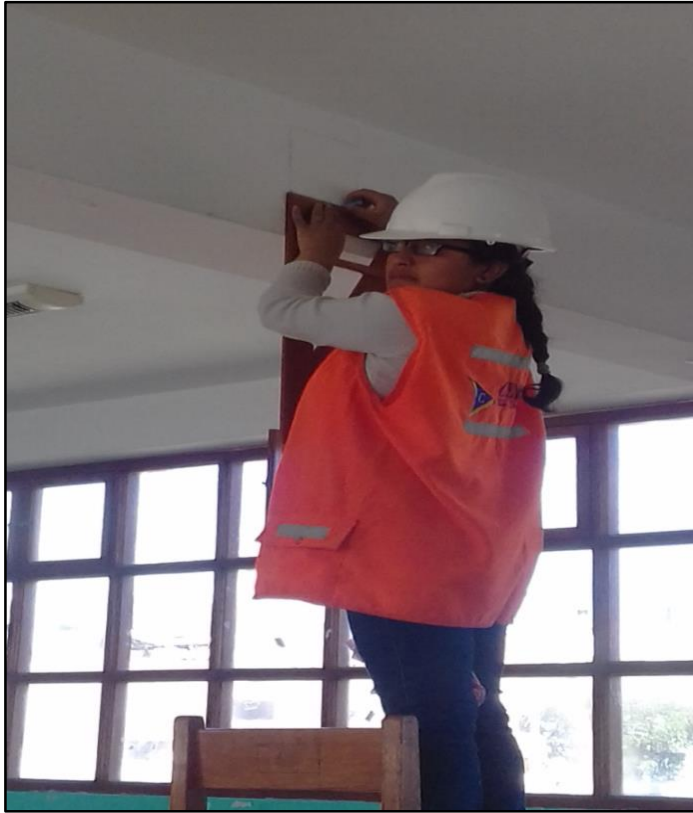
FOTO N° 13: Realizando trazo para el corte del tarrajeo en vigas.
