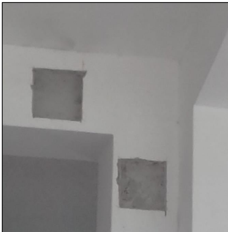
FOTO N° 20: Corte de tarrajeo listo
