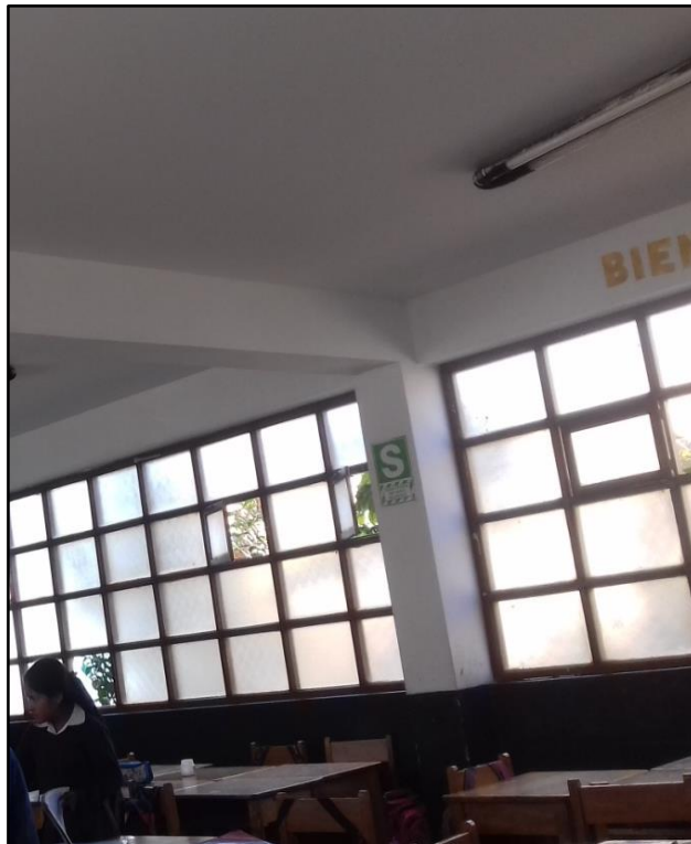
FOTO N° 10: Unión vigas –columnas en pórticos
