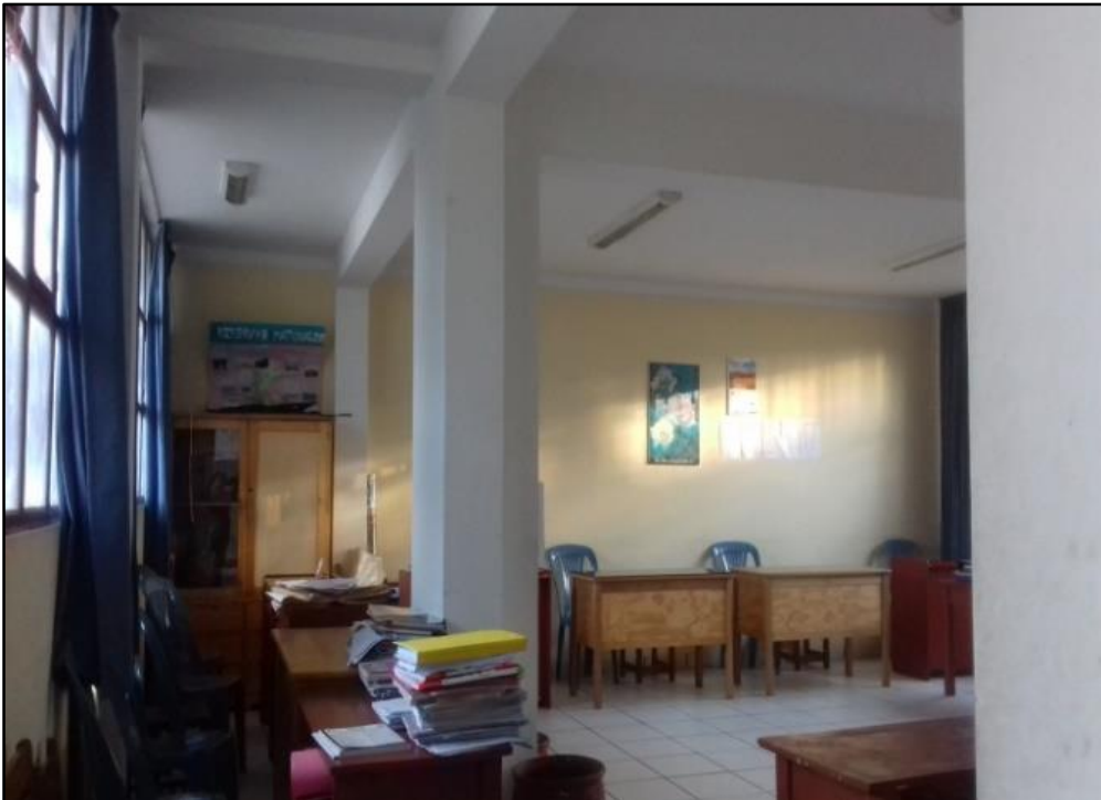
FOTO N° 11: Sistema aporticado con columnas T de la sala de profesores
