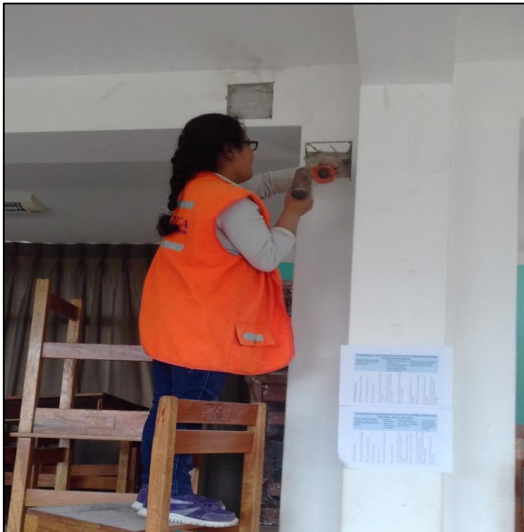
FOTO N° 18: Picado de tarrajeo en columnas T
