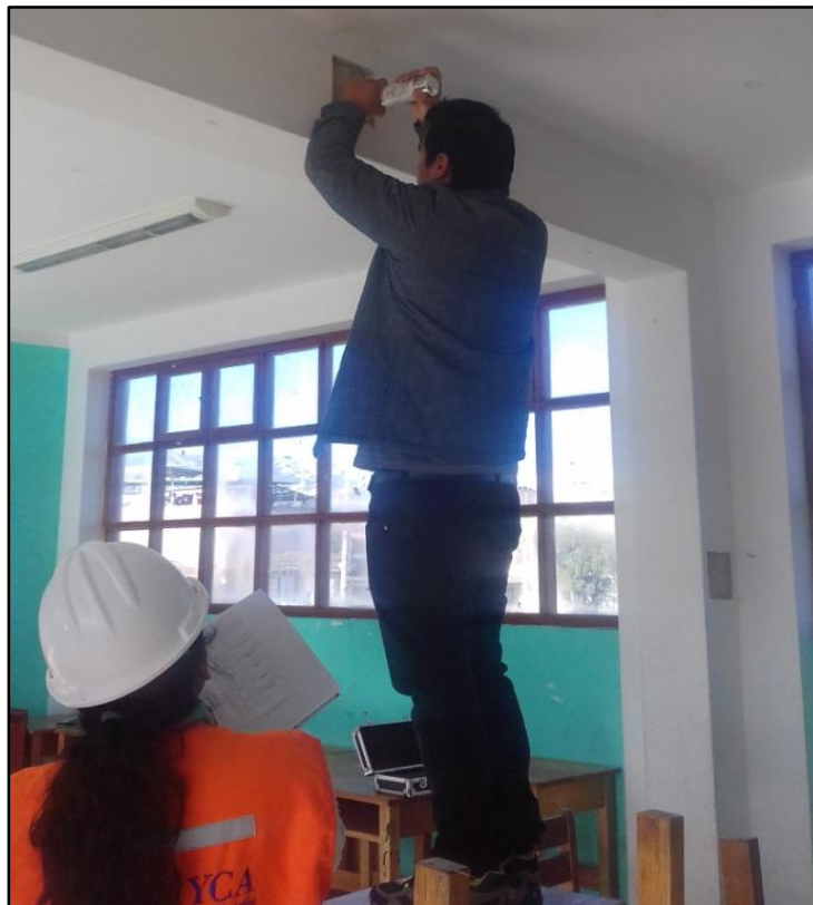
FOTO N° 28: Realizando el ensayo de esclerometría en viga
