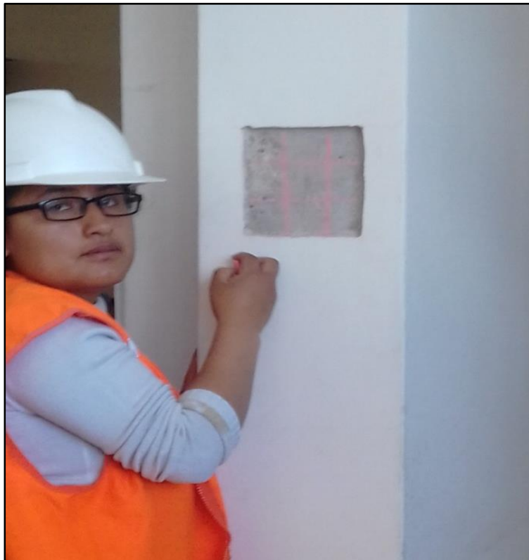
FOTO N° 22: Trazo de recuadros de 15cm x 15cm para el ensayo esclerometría en columna
