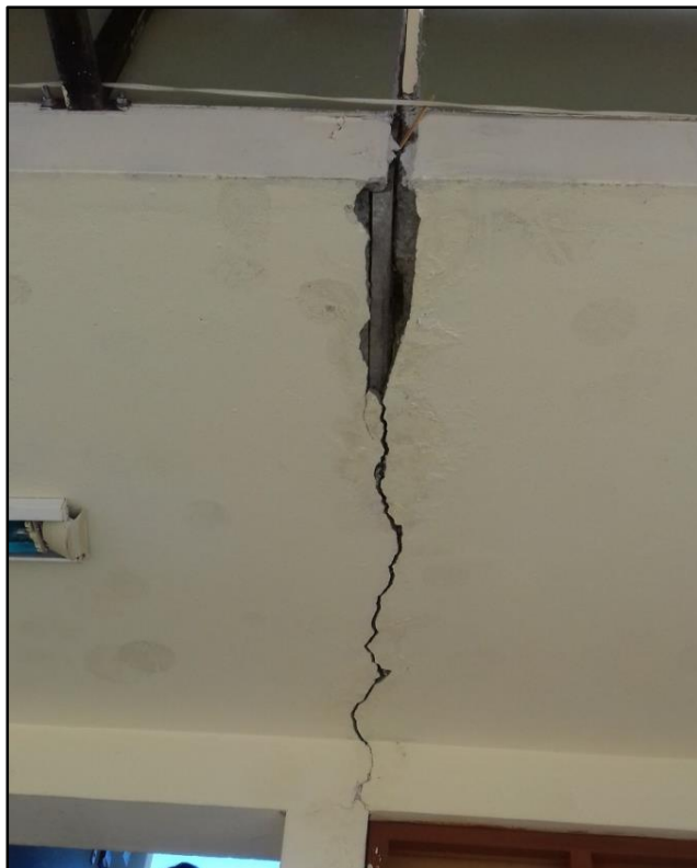
FOTO N° 8: Junta sísmica en losa del primer nivel
