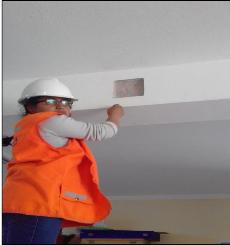
FOTO N° 21: Trazo de recuadros de 5cm x 5cm para el ensayo esclerometría en vigas
