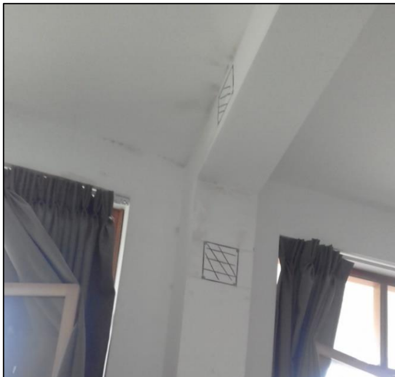
FOTO Nº 16: Tarrajeo cortado, listo para el picado
