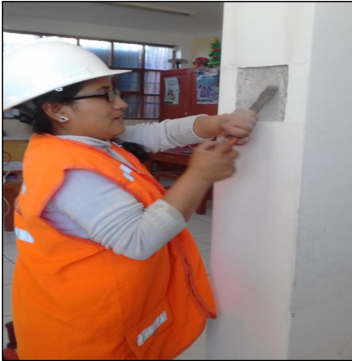
FOTO N° 19: Terminando de picar el tarrajeo
