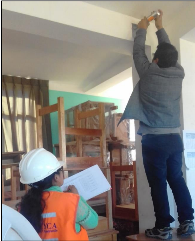
FOTO N° 31. Realizando el ensayo de esclerometría en segundo nivel
