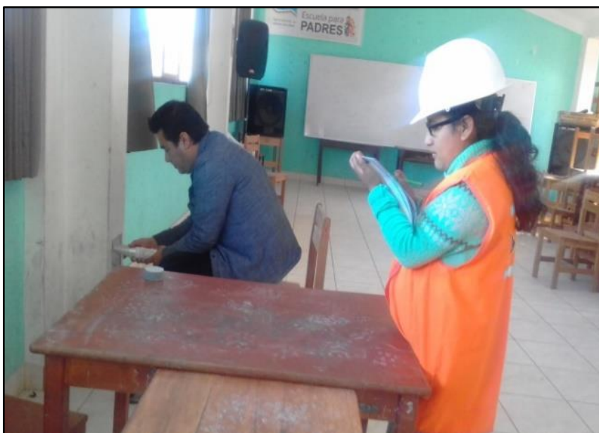
FOTO N° 26: Realizando el ensayo de esclerometría parte inferior de columna
