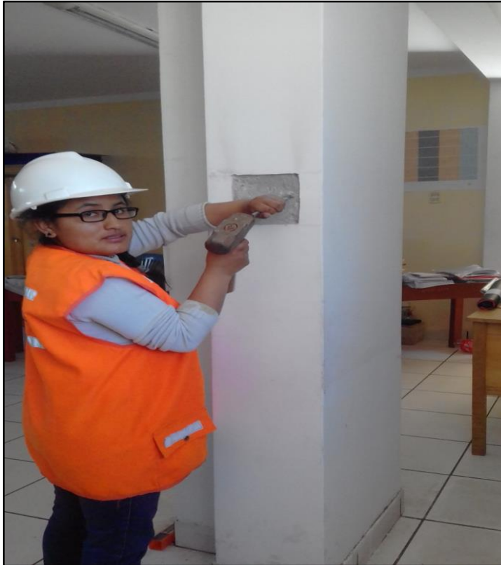
FOTO N° 17: Picado de tarrajeo de columnas
